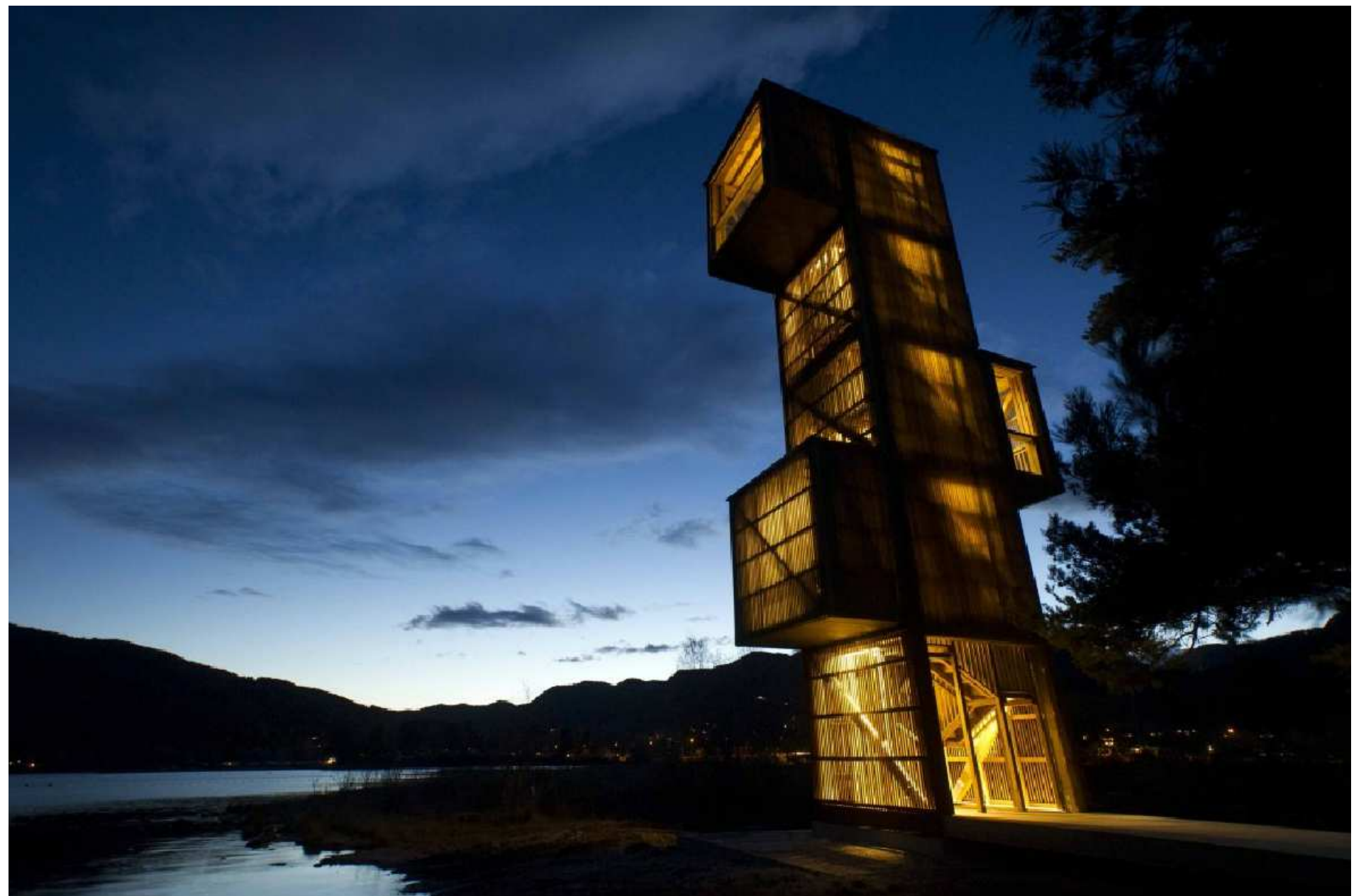
Rintala Eggertsson architects, Torre de observación paisajística en el lago Seljord (2009)
