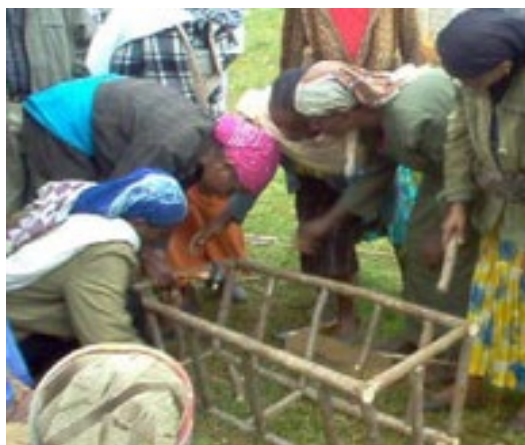
Figura 1.6. Construcción de colmena tradicional usando material local, provincia de Zambezia.
