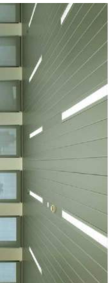
Falso techo acústico de bandejas de madera. Hunter Douglas (salón de actos)
