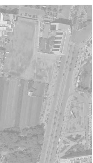
Vista aérea SUR
