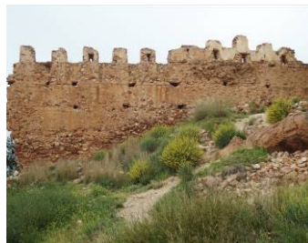
Fig. 4.16- Muro Norte desde el interior.
