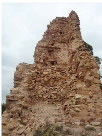
Fig. 4.17- Torre Noroeste vista desde el Sur.
