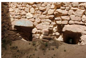
Fig. 4.8- Aspilleras nivel suelo.
