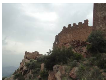
Fig. 4.15- Vista general muro Este visto desde el exterior.
