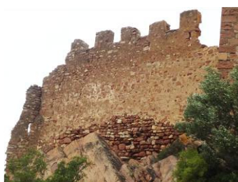
Fig. 4.15- Muro Este visto desde el exterior.
