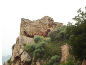
Fig. 4.15- Muro Este visto desde el exterior.
