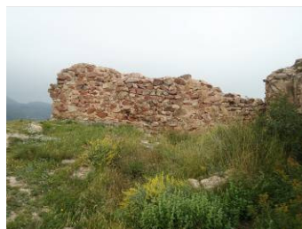
Fig. 4.15- Muro Este visto desde el interior.
