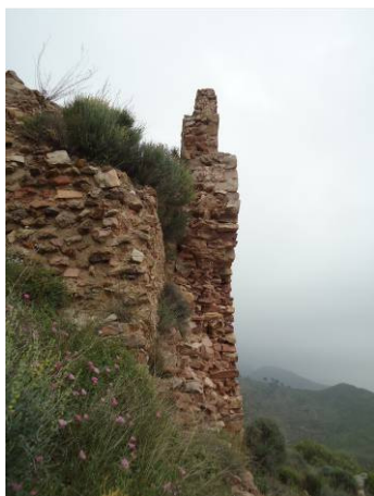
Fig. 4.13- Muro Sur visto exteriormente.
