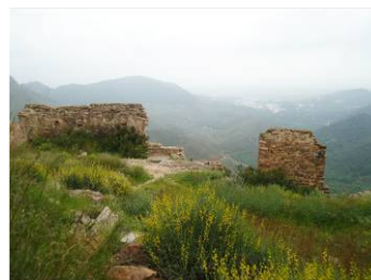
Fig. 4.14- Vista general muro Sur.
