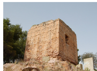
Fig. 2.9- Torre de la Ermita
