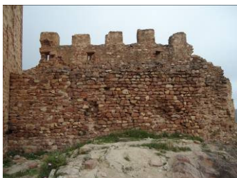
Fig. 4.15- Muro Este visto desde el interior.
