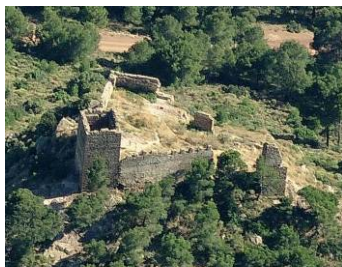
Fig. 4.16- Muro Norte mediante Blom Urbex.
