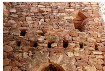
Fig. 4.11- Aspilleras nivel suelo.
