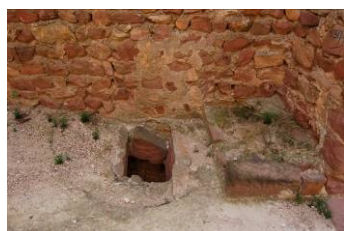
Fig. 4.10- Arranque de escalera.
