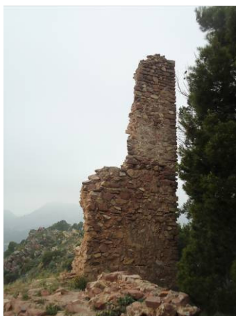
Fig. 4.17- Torre Noroeste vista desde el Este.
