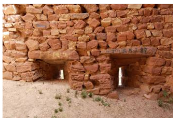
Fig. 4.8- Aspilleras nivel suelo.
