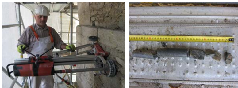
Figura 5: Extracción de testigos continuos [7]
