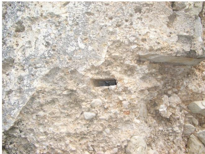
*Figura 3.1.1.3 Orificio provocado por el travesañó del tapial, ocasionado en su retirada.*
