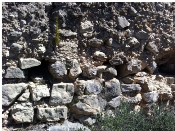
*Figura 3.1.1. Base de mampostería para salvar los desniveles del terreno. Sobre la misma se observan algunas de las aspilleras ubicadas en la muralla*
