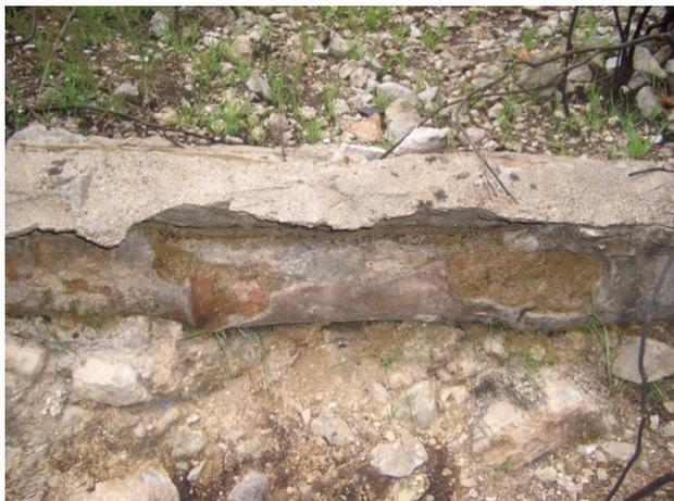
*Figura 2.6.3. Canalización con teja curva*
