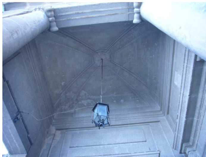
Fotografía 80. Bóveda en rincón de claustro, acceso Norte.
