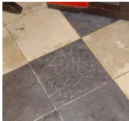
Fotografía 136. Baldosa agrietada.
