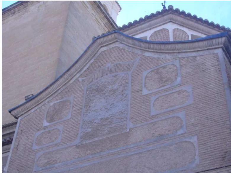
Fotografía 68. Revestimiento exterior Capilla de la Comunión.
