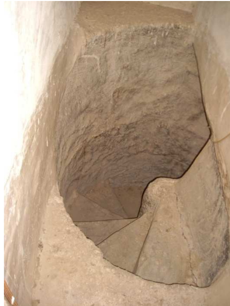
Fotografía 73. Desembarco de la escalera de caracol.
