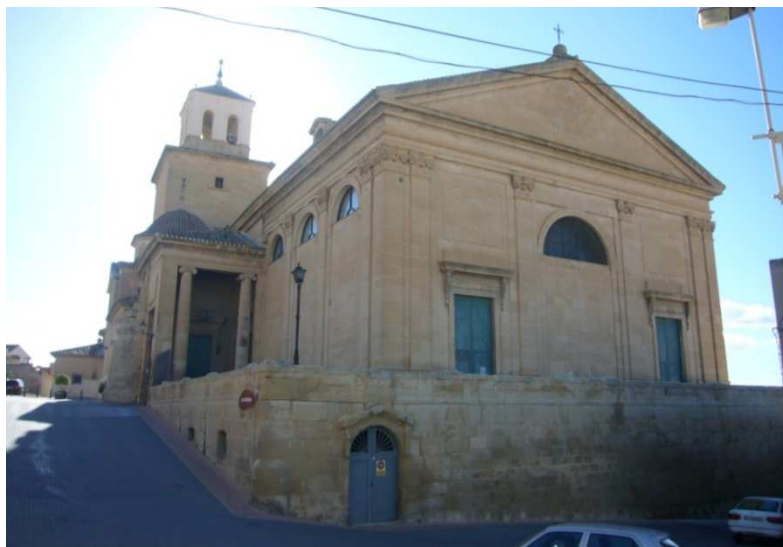
Fotografía 25. Encuentro muro de contención Norte y Oeste.
