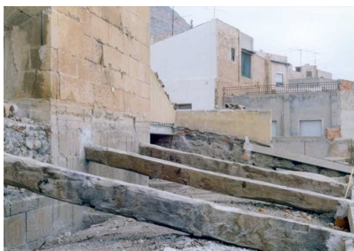
Fotografía 38. Intervención cubiertas, 1992. Plácido Cañadas.
