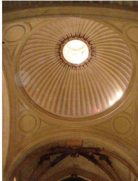
Fotografía 12. Arco de medio punto, originalmente apuntado. Plácido Cañadas.
