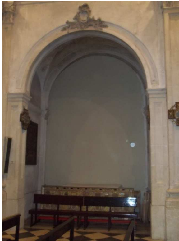
Fotografía 147. Segunda capilla lado derecho, partición posterior de cartón-yeso.
