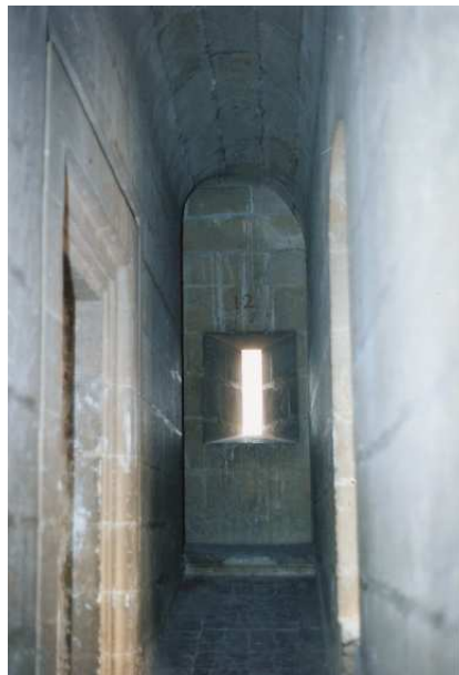
Fotografía 72. Rampa entre los anillos de la torre, 1992. Plácido Cañadas.
