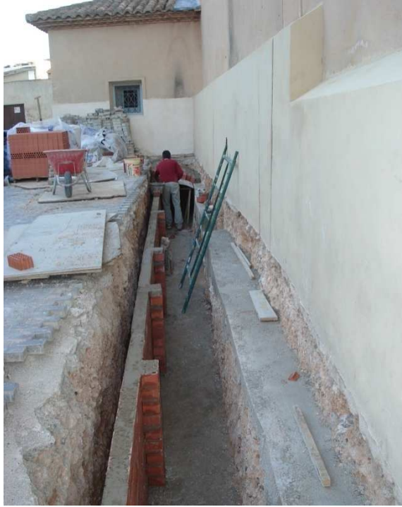
Fotografía 122. Ejecución de cámara bufa, 2007. Plácido Cañadas.
