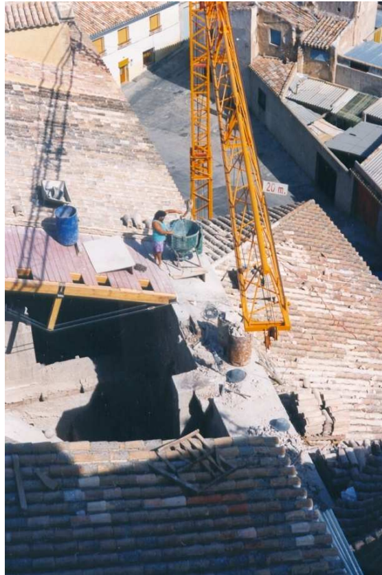
Fotografía 39. Nueva cubierta, 1992. Plácido Cañadas.
