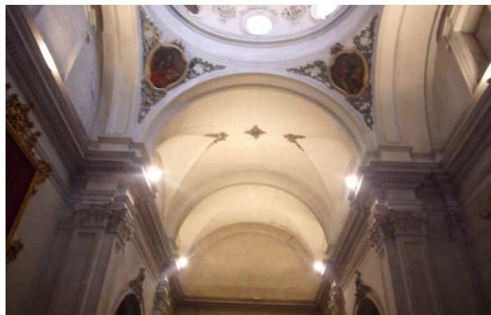
Fotografía 66. Bóveda Capilla de la Comunión.
