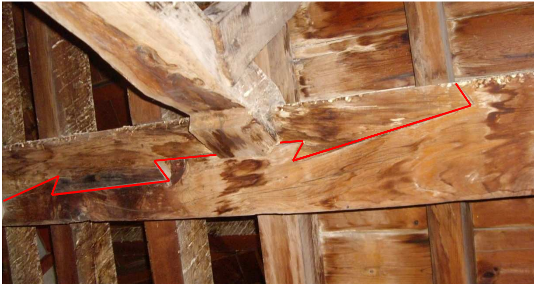
Fotografía 10. Detalle de ensamble en rayo de Júpiter.
