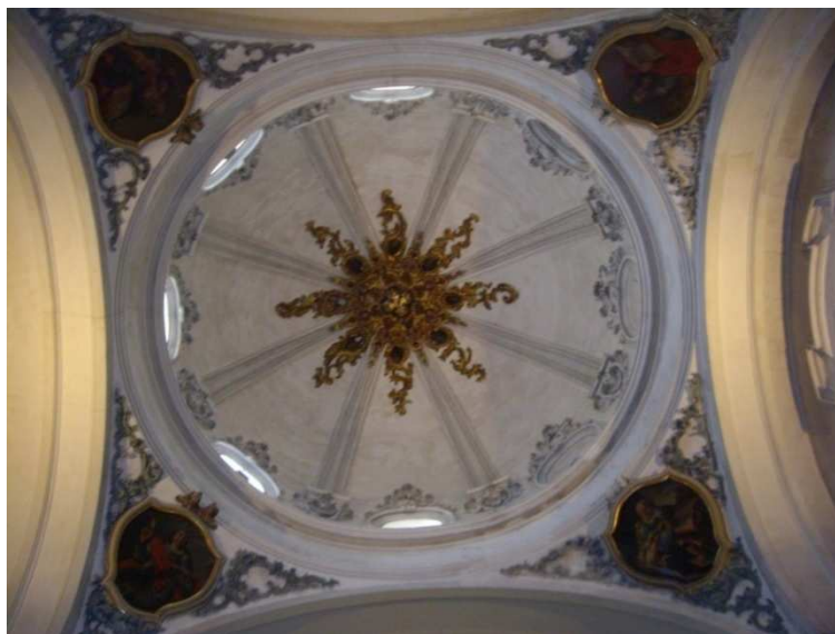
Fotografía 24. Cúpula sobre falso crucero de la Capilla de la Comunión.
