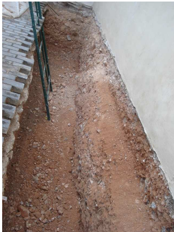
Fotografía 121. Excavación para cámara bufa, 2007. Plácido Cañadas.
