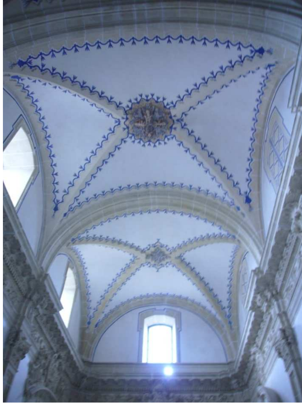
Fotografía 87. Bóveda de cañón con lunetos, Sacristía Nueva.
