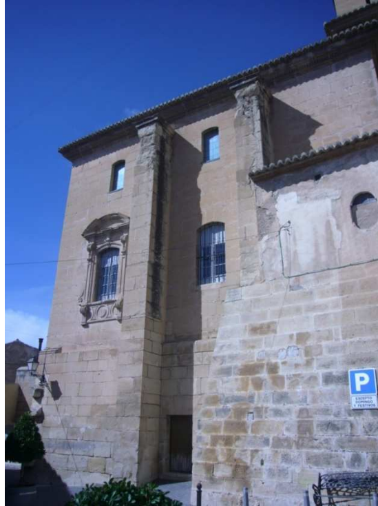
Fotografía 67. Muro de levante Sacristía Nueva, desde replaceta de Abajo.
