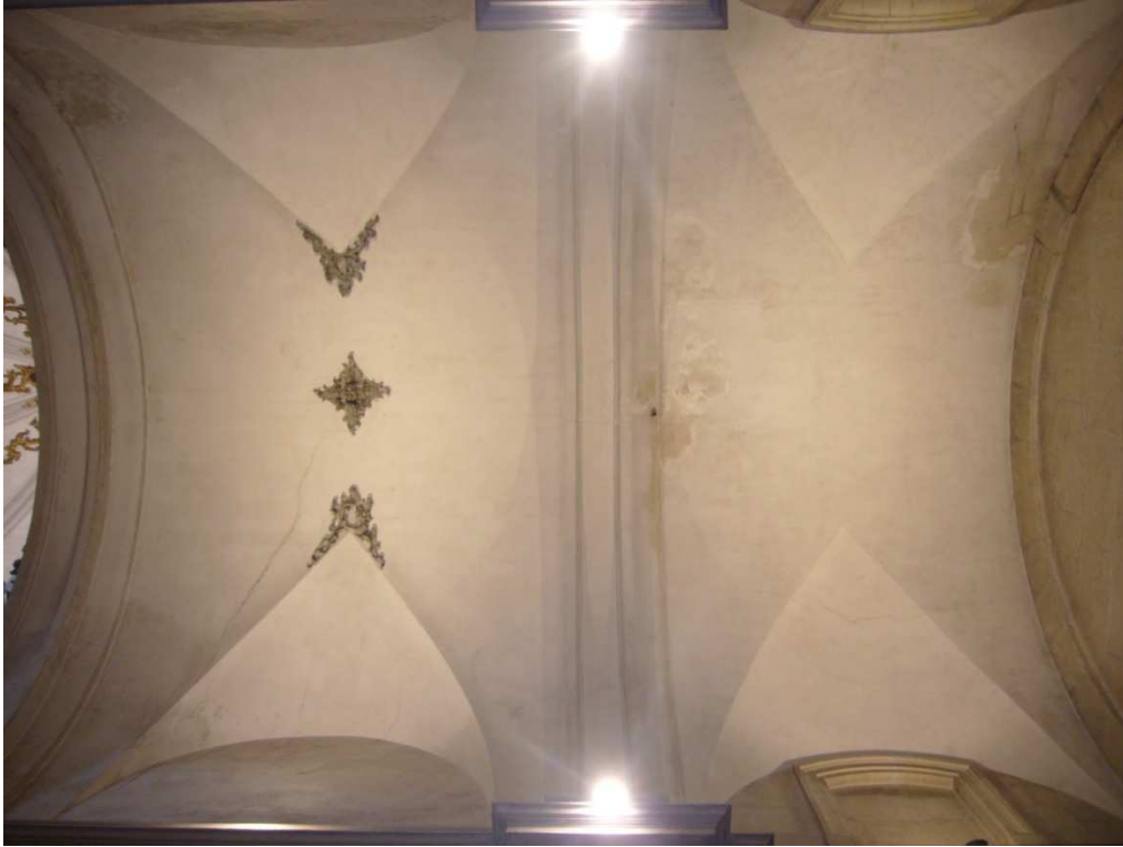
Fotografía 108. Intradós bóveda de cañón y arcos fajones.
