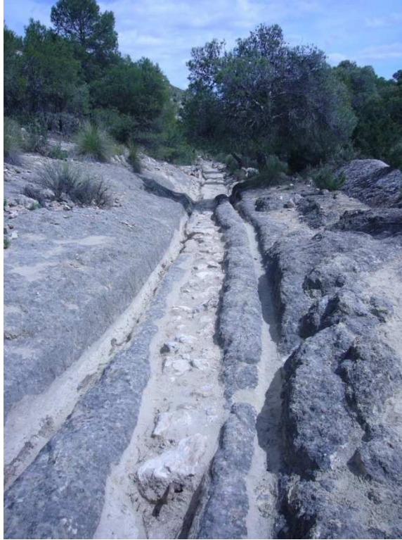
Fotografía 128. Camino histórico de La Pedrera, Bien de Interés Cultural. Carriladas excavadas en la roca para facilitar el paso de los carros.
