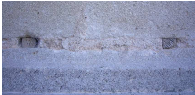
Fotografía 61. Cuñas de madera para colocación de los sillares, muro neoclásico Norte.
