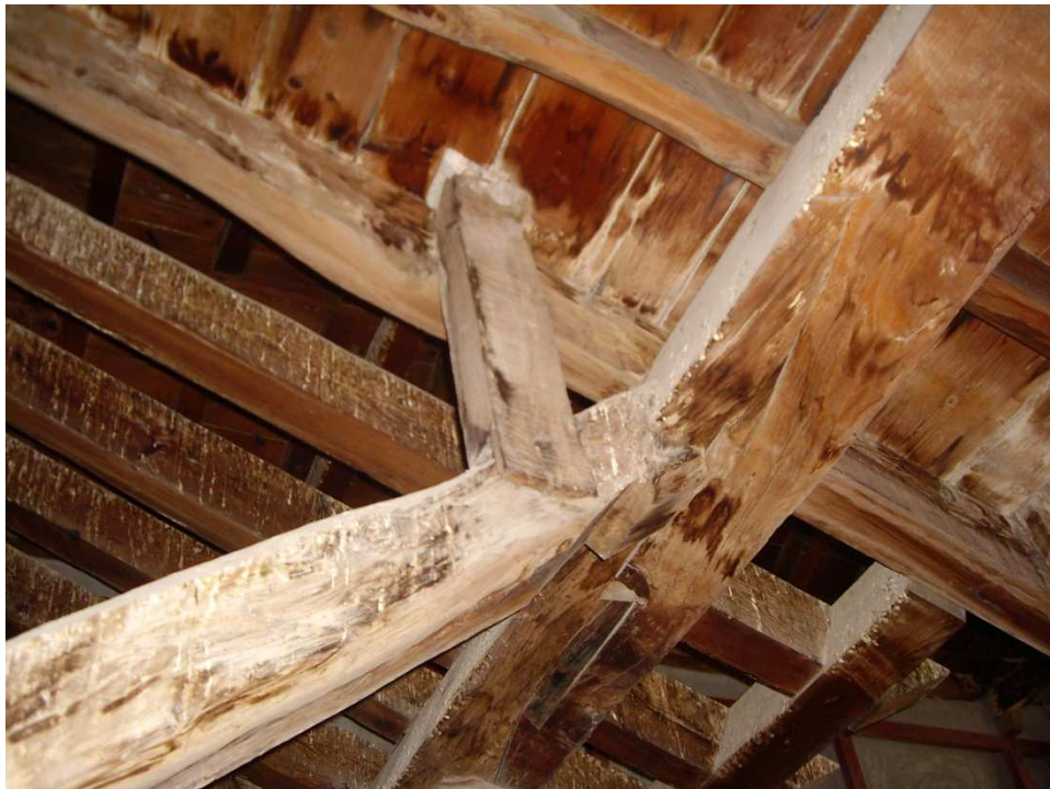
Fotografía 9. Estructura de cubierta original.
