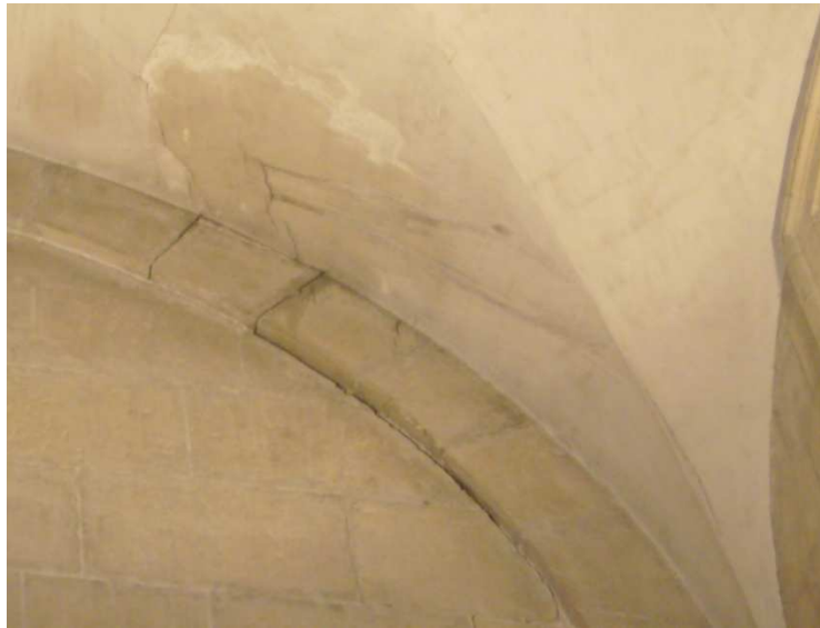
Fotografía 140. Vaciado de juntas, muro Oeste.
