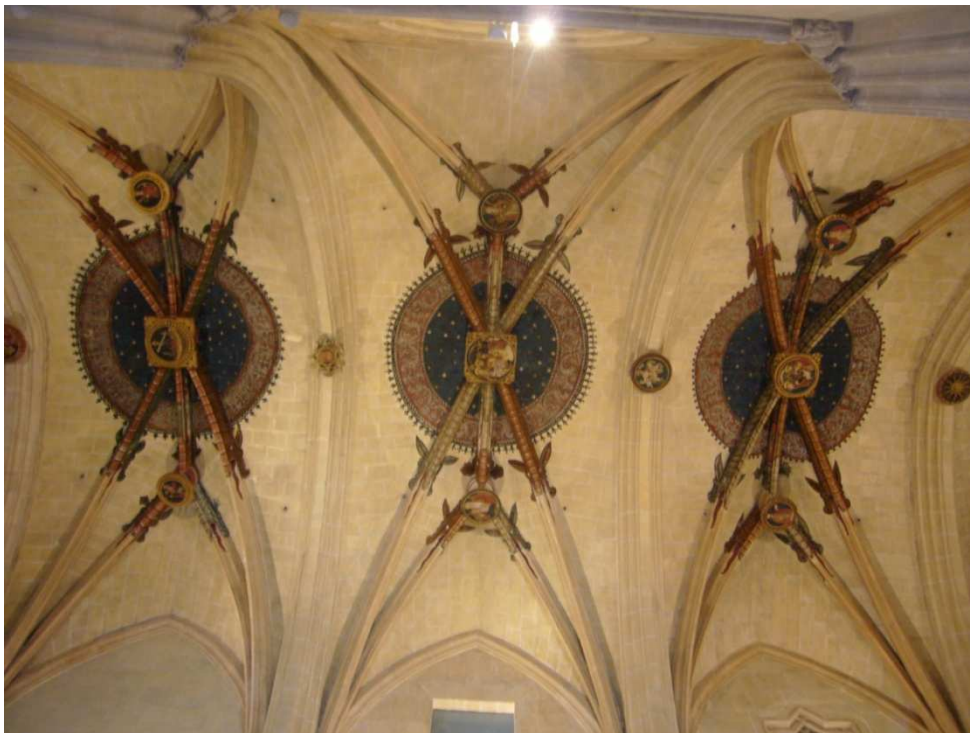
Fotografía 4. Ménsulas policromadas, nave central.
