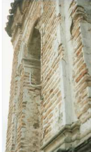
Fotografía 18. Cuerpo final de la torre, antes de su restauración, 1992. Plácido Cañadas.
