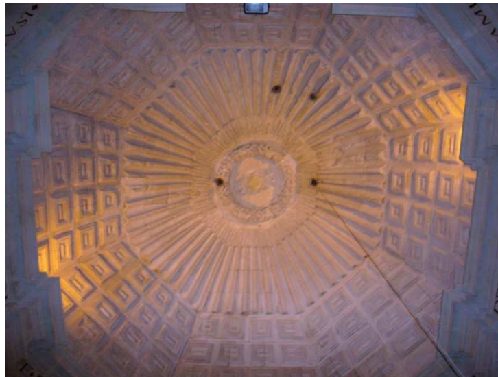
Fotografía 13. Cúpula Sacristía Vieja.
