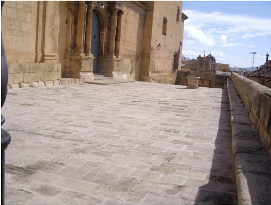
Fotografía 41. Atrio Sur, estado actual.
