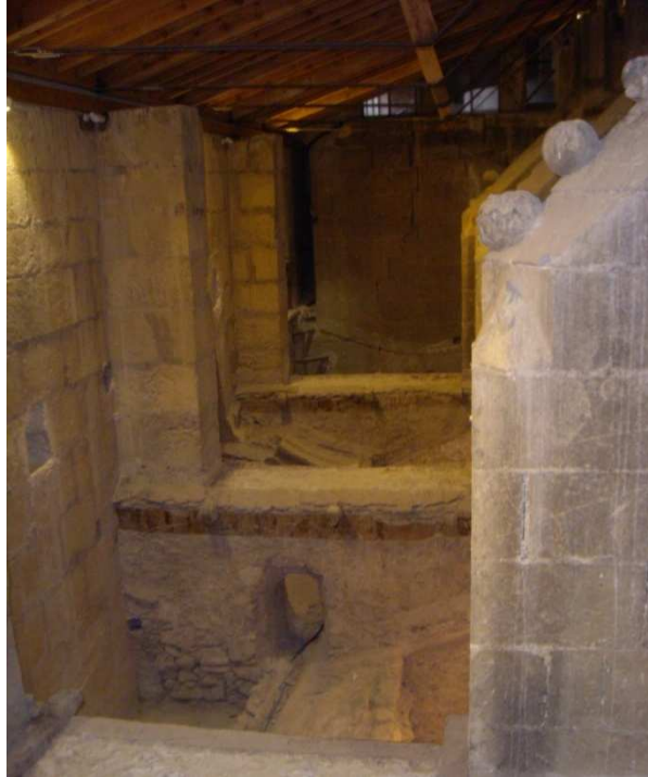
Fotografía 45. Espacio gótico, lado Norte, bajo cubierta.
