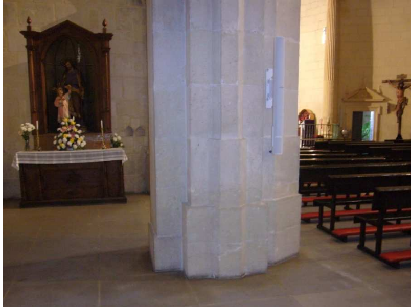
Fotografía 64. Pilar nave central.
