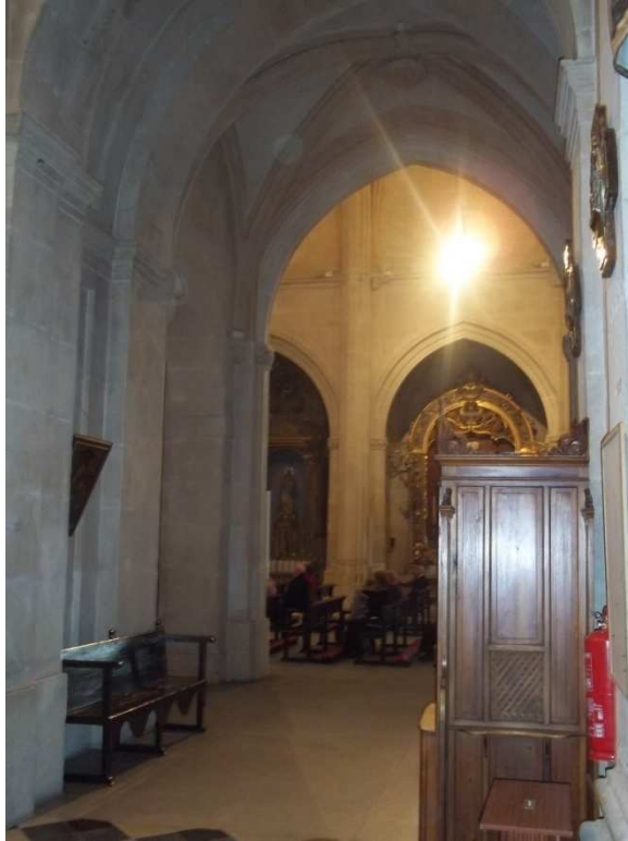
Fotografía 118. Comunicación con nave central.
