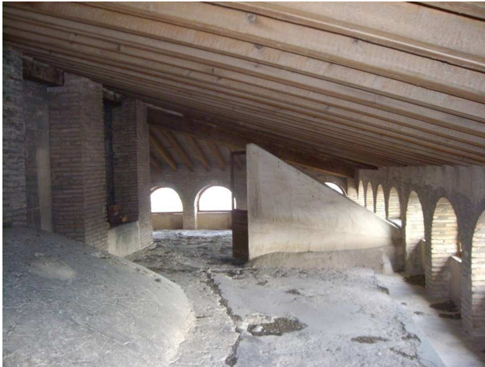
Fotografía 102. Última altura sobre la cabecera, parte superior de los ábsides.
