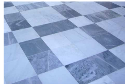
Fotografía 82. Pavimento Sacristía Nueva.
