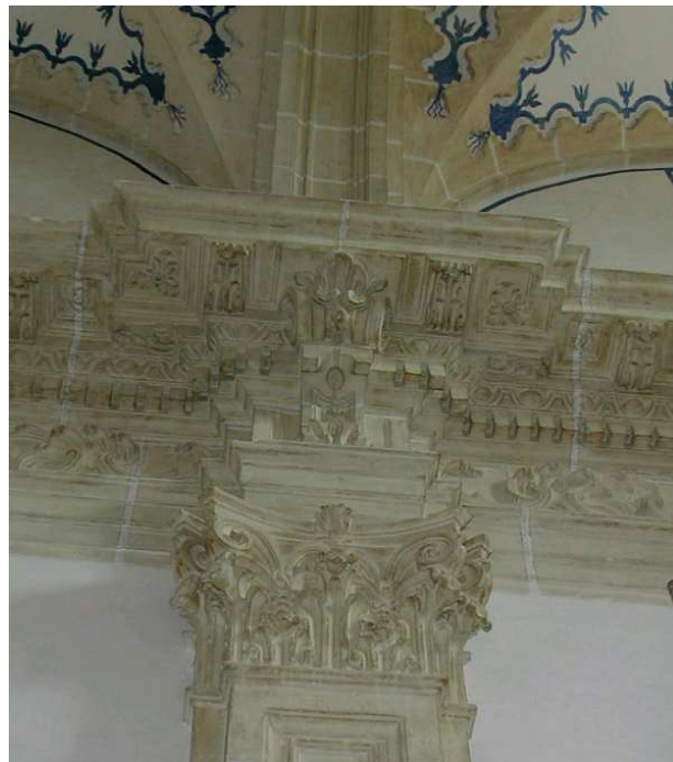
Fotografía 88. Detalle pilastra bajo arco fajón en bóveda Sacristía Nueva, durante su restauración, 2006. Plácido Cañadas.
