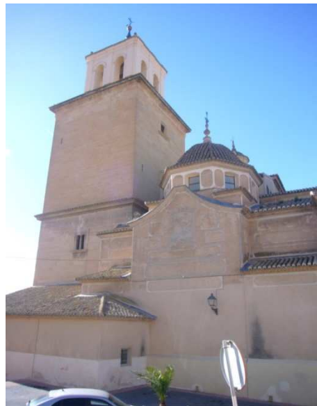
Fotografía 17. Torre desde C/ del Hospital Viejo.
