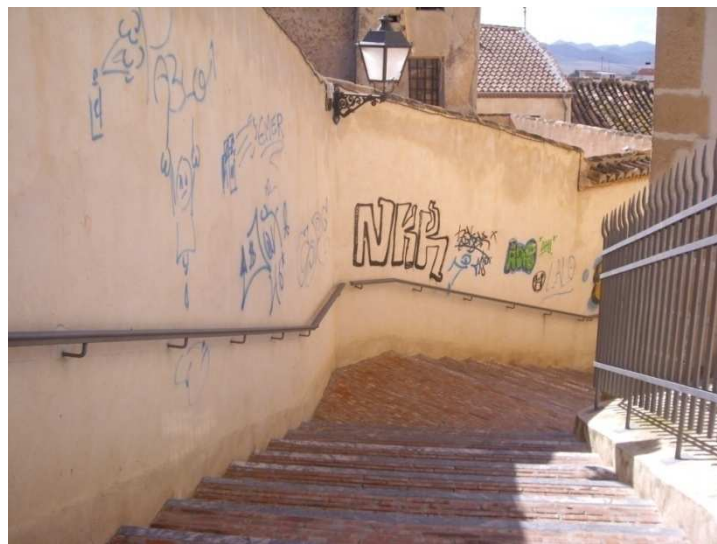
Fotografía 42. Escalera de conexión entre las dos replacetas.
