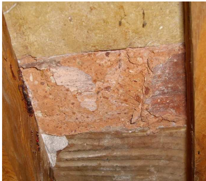
Fotografía 143. Ladrillo afectado.
