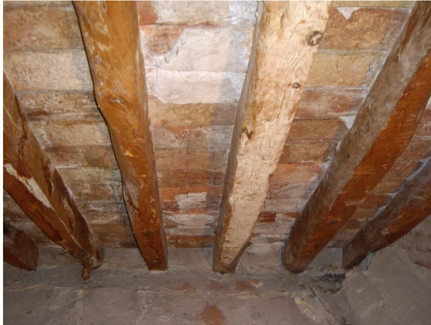
Fotografía 142. Tablero cerámico sobre pares de cubierta.
