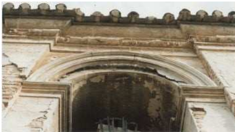
Fotografía 19. Campanario, antes de su restauración, 1992. Plácido Cañadas.
