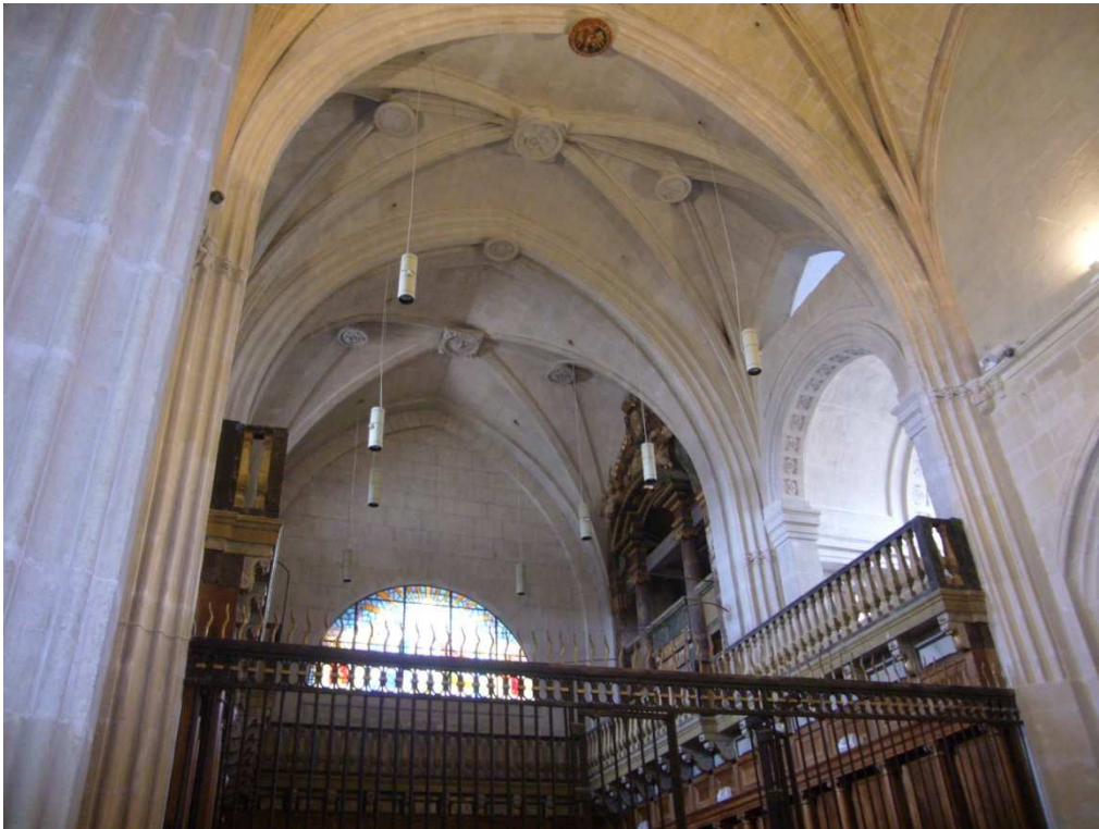
Fotografía 89. Bóveda de cañón capillas laterales del coro, primer tramo.
