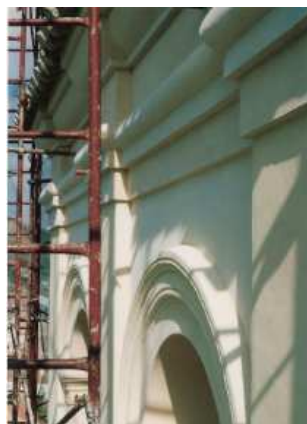
Fotografía 70. Revestimiento campanario tras su restauración, 1992. Plácido Cañadas.
