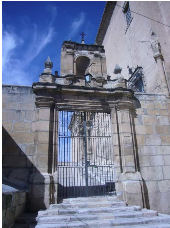
Fotografía 20. Portada de acceso al atrio Sur desde la calle de Santiago.
