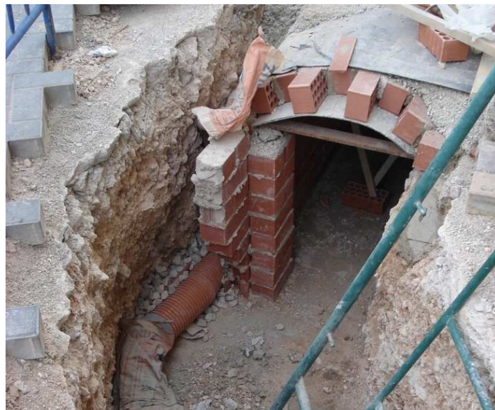
Fotografía 44. Creación de cámara bufa por el exterior de la Cripta Norte. Plácido Cañadas.
