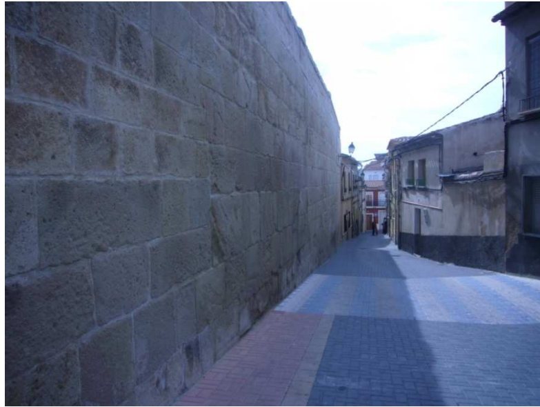
Fotografía 26. Muro de contención Oeste, calle de Cuatro Cantones.
