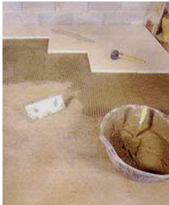
**Imagen 17: Ejemplo de colocación con cemento cola**
