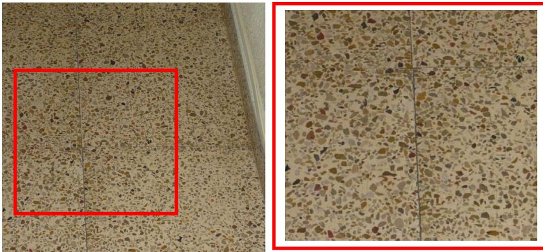
**Imagen 12: Junta abierta debido a una insuficiente junta perimetral**
