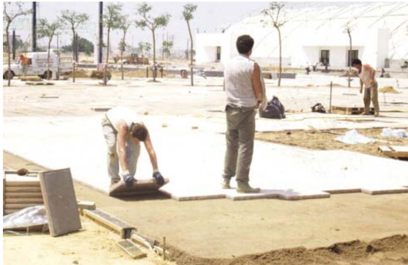
**Imagen 16: Colocación sobre árido**
