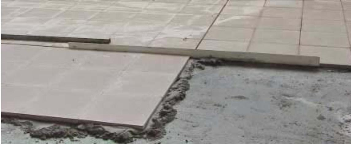
**Imagen 15: Colocación sobre mortero a punta de paleta**
