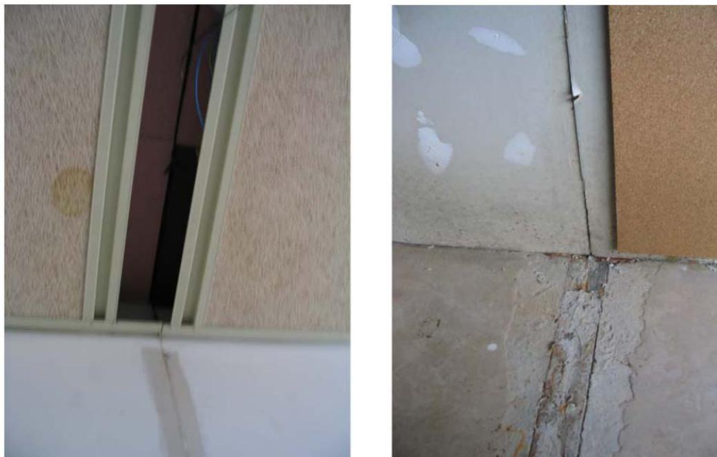
*Fotos de juntas entre módulos que han de resolverse en obra*
