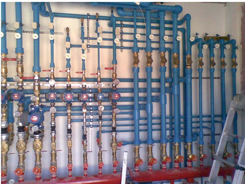
*Conducciones de calefacción en fase de ejecución*
