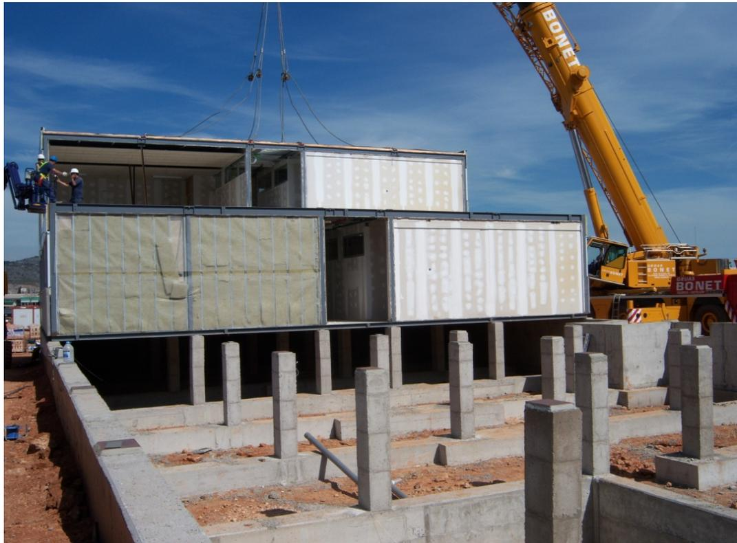
*Montaje de módulos en dos planta en CEIP nuevo nº 2 en Finestrat*
