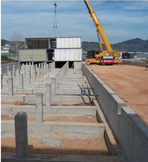
*La cimentación recibe la carga de los módulos a través de las placas*
