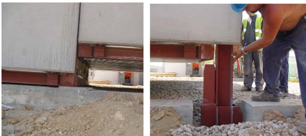
*Fotos del proceso de unión de los módulos con los cimientos*
