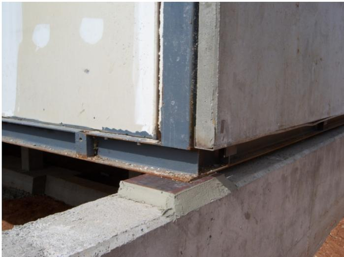
*Apoyo estructural de modulo con placa en cimentación*
