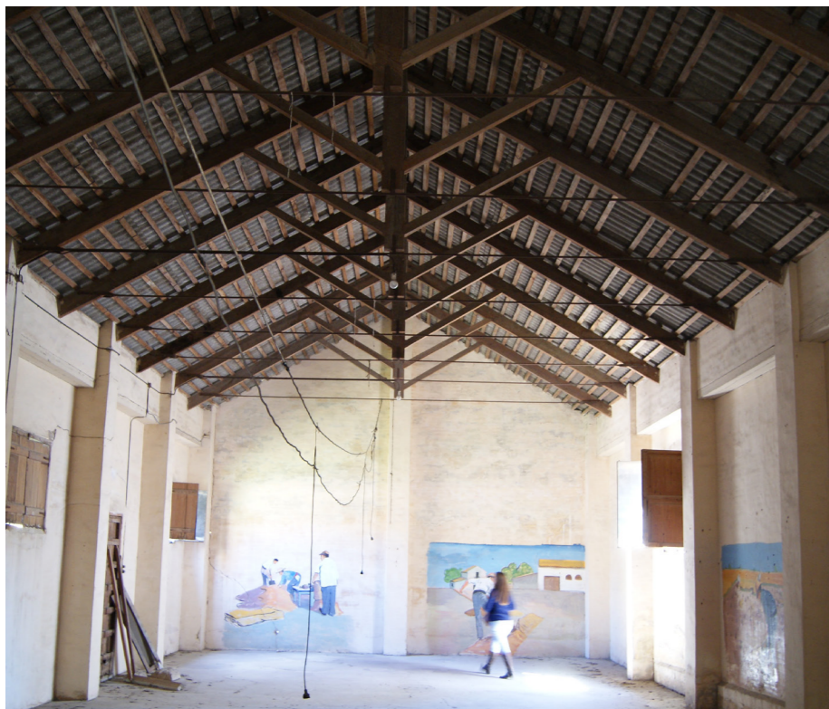
Cerchas de madera
