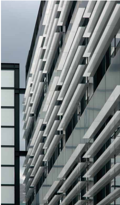
11 Detalle fachadas edificio
