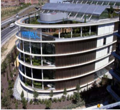
2 Vista general del edificio Sanitas
