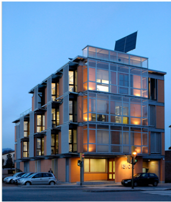
23 Imagen del edificio terminado
