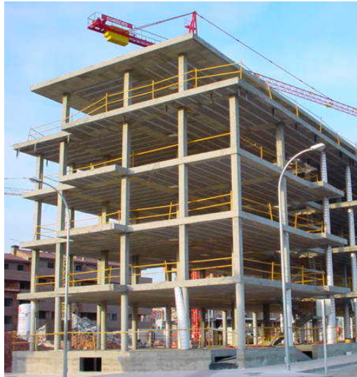
9 Edificio de estructura de hormigón armado
