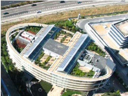
5 Vista semiaérea del edificio, con las instalaciones en cubierta
