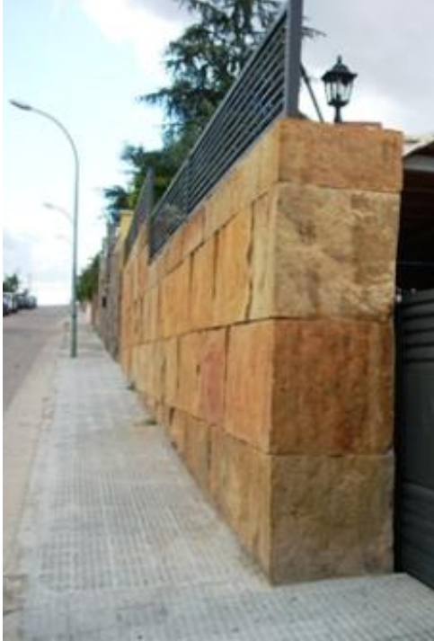
12 Usos de áridos reciclados en muros prefabricados
