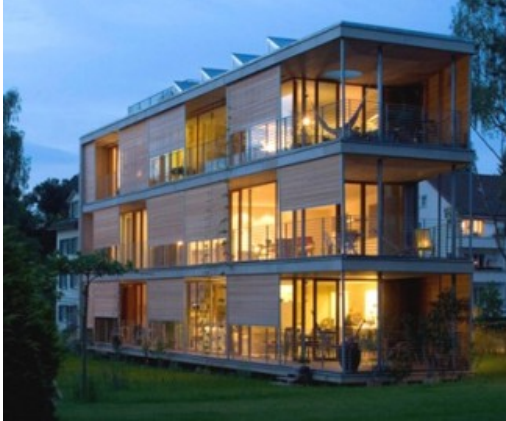
3 Edificio de apartamentos en Berna (Suiza) Premio 2010 Passivhaus, con certificado Minergie
