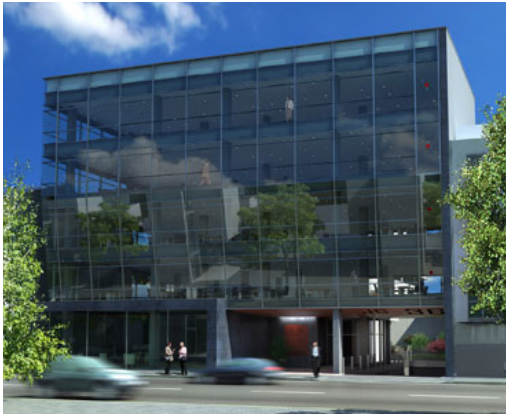
5 Edificio de oficinas en Madrid, con certificado BREEAM, y calificación "muy buena"
