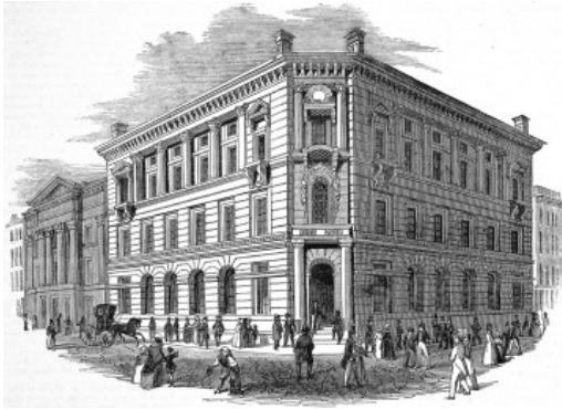
8 Life and British Fire Office, de Cockerell, en Londres
