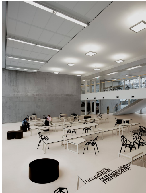
14 Pavimento de linóleo
