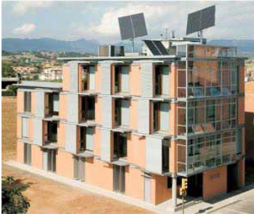
22 Imagen del edificio en construcción
