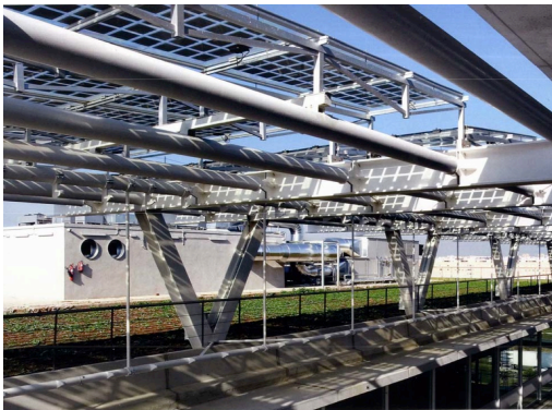
17 Detalle zona cubierta
