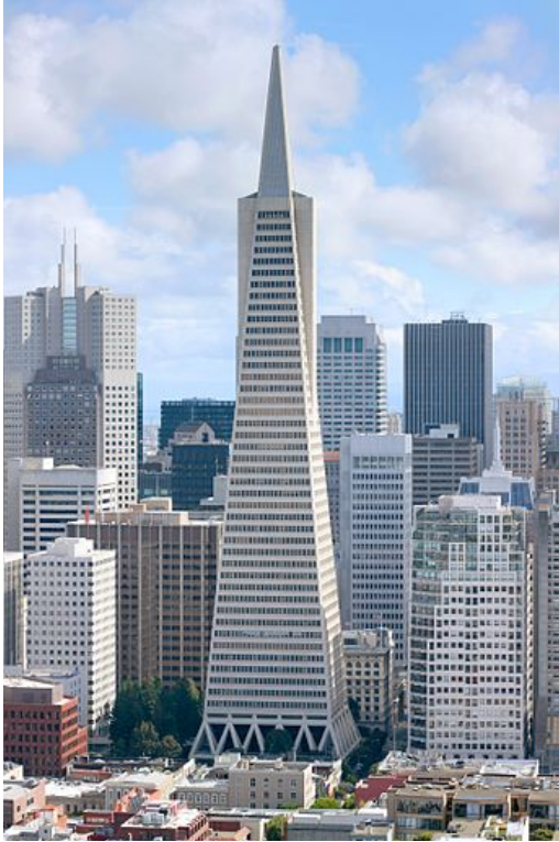
4 Edificio Transamerica Pyramid en San Francisco (EEUU) es un rascacielos de oficinas con certificación LEED oro
