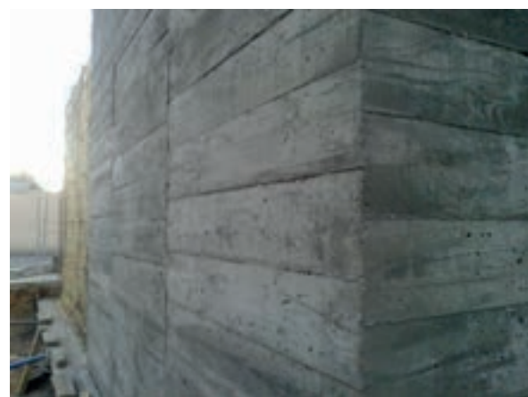
Esquina acabada de hormigón tableteado horizontal
