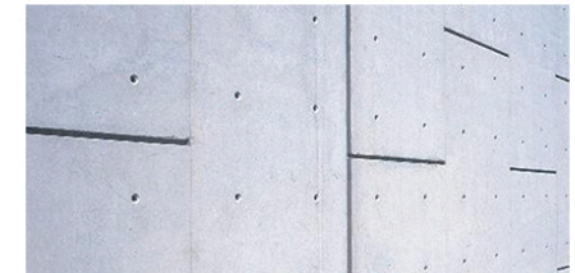
Acabat formigó amb encofrat "Vistaform recto"
