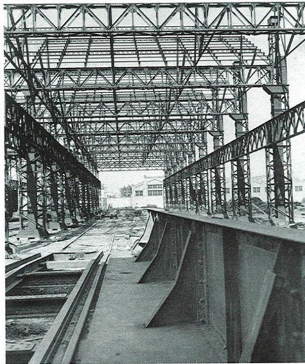
Ampliació, alçament de naus de màquines i ferramentes, vista desde sud, amb el transbordador DEVIS de 60 Tn. 1936
