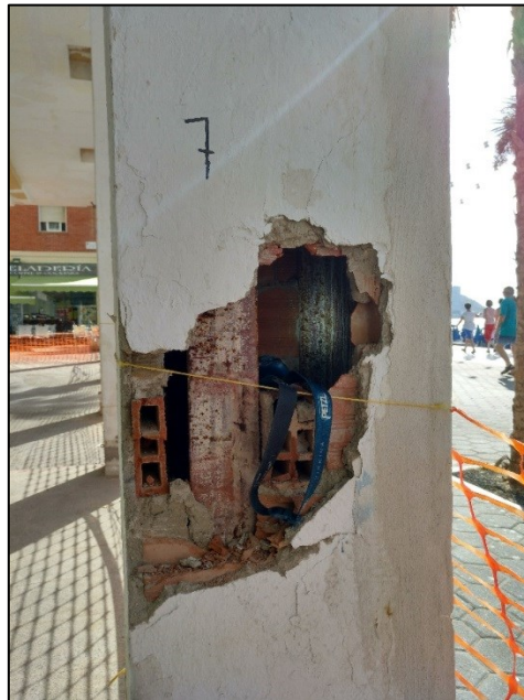
Figura 23. Muestro de pilar
