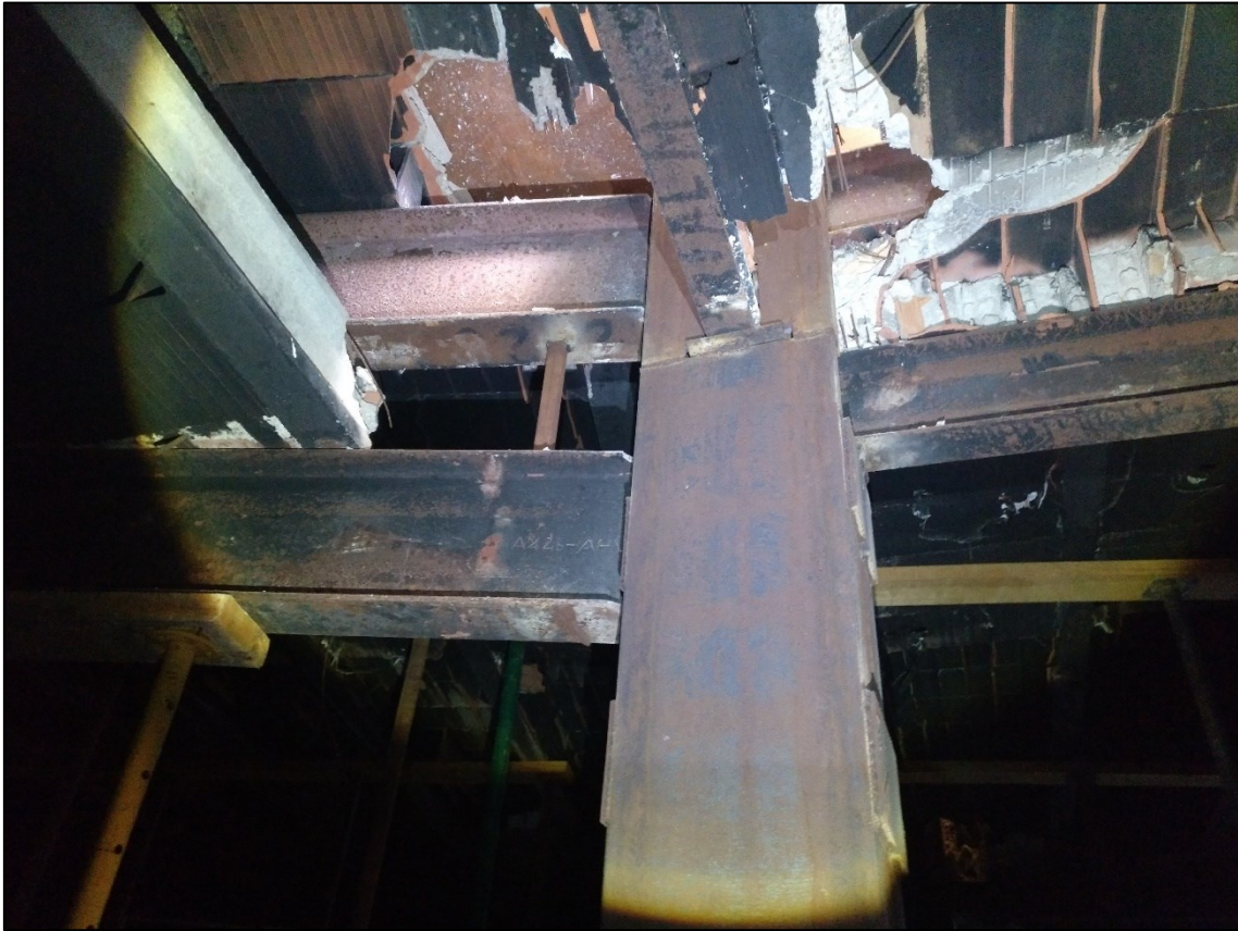
Figura 26. Refuerzo de vigas
