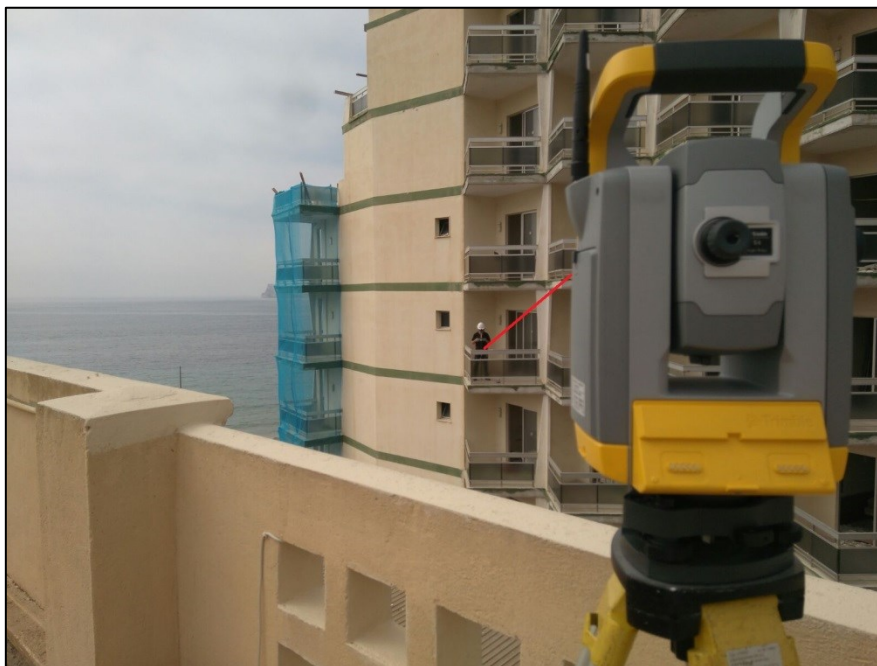
Figura 5. Observación topográfica de la fachada
