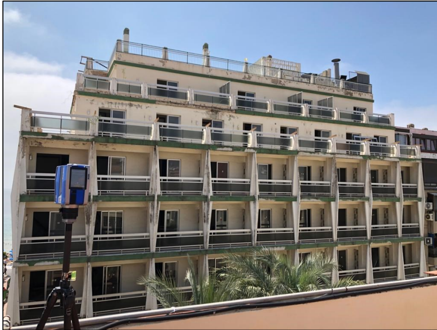
Figura 8. Escaneo de fachadas
