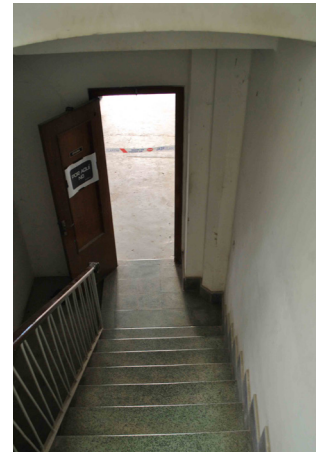
Acceso desde la calle al altillo
