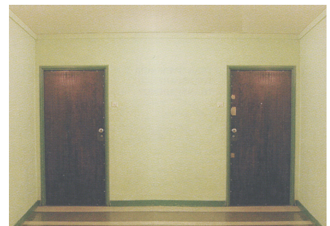
Estado actual de los rellanos. Ejemplo aplicable de PLUS: la vivienda colectiva, territorio de excepción . Druot, Lacaton y Vassal.
