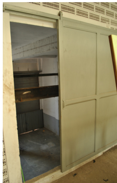
comunicación del altillo con la planta baja
