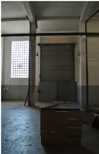
puerta de acceso a la Calderería
