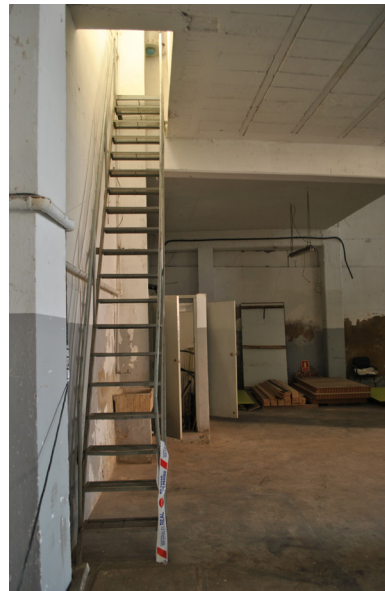
acceso al altillo desde la Calderería
