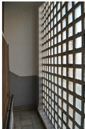
descansillo de la escalera
