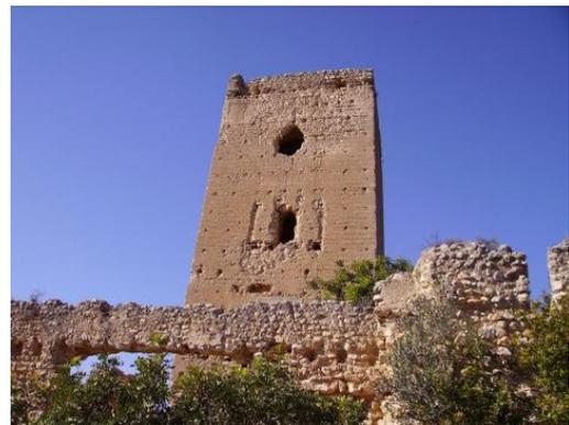
Restos de vegetación muy cercanos a la construcción como podemos apreciar en la imagen, provocan empuje en ciertas zonas del muro.
