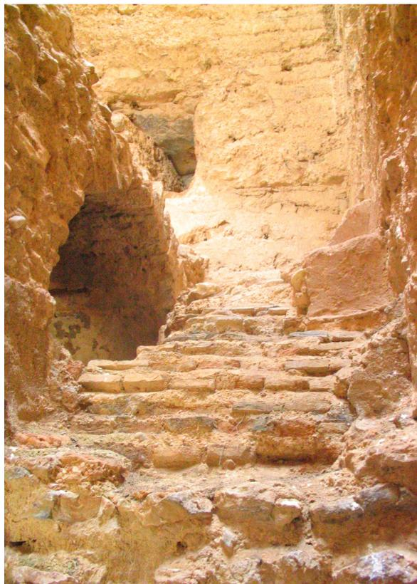
Escalera realizada mediante mampuestos seleccionados, ordenados y ladrillos de barro unidos con argamasa y arena humedecida y posiblemente cal, se aprecia el estado muy deteriorado y como deja a un lado unas de las bóvedas parcialmente demibadas para su
