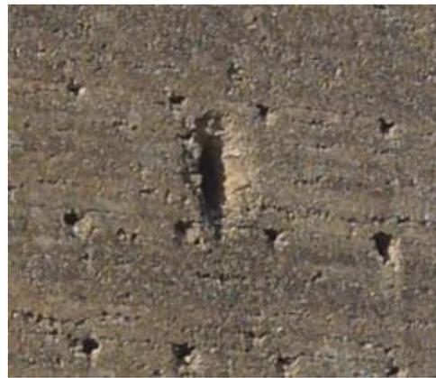
En esta saetera no se puede identificar tan claramente el dintel ni el abocinamiento la causa puede ser el deterioro o ejecución distinta a la primitiva
