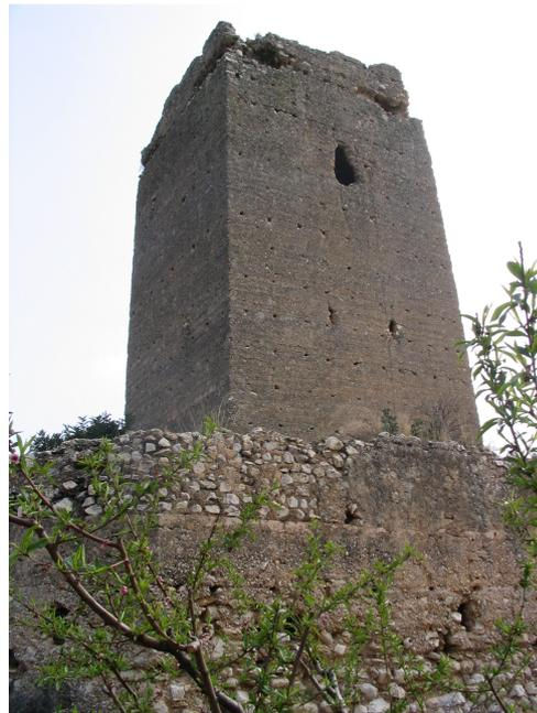
En la cara Oeste en parte superior se puede apreciar un vano de dimensiones mayores a las de una saetera, podría ser de construcción posterior a la primitiva.
