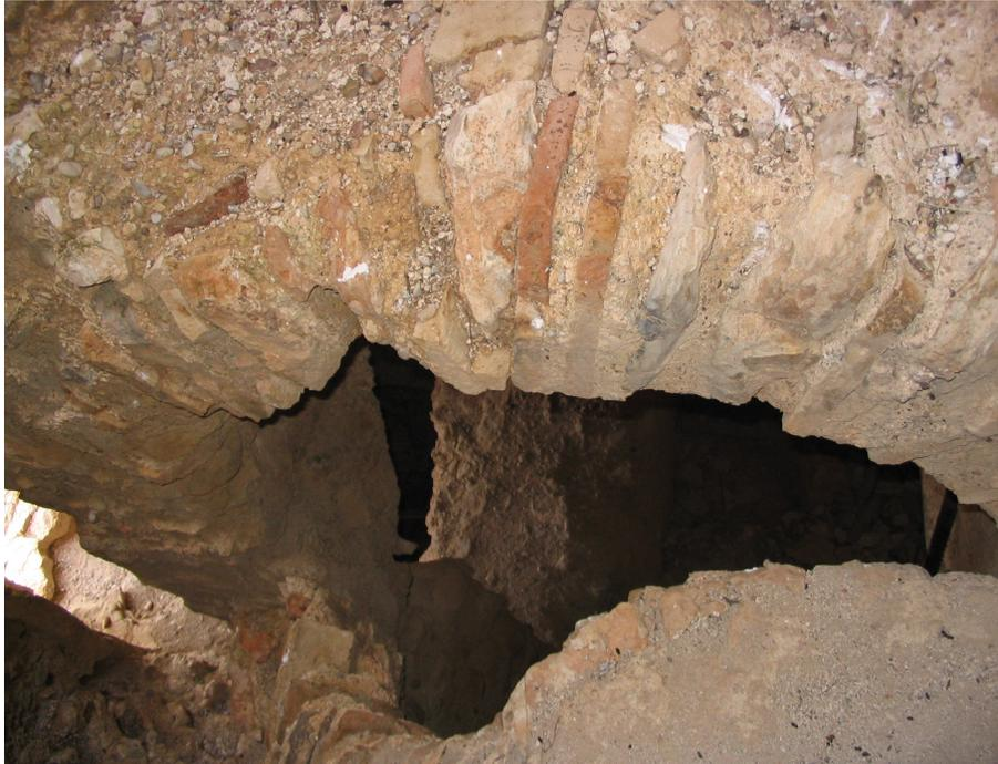
Construcción de la bóveda con ladrillos y mampuestos seleccionados colocados a rosca y unidos mediante argamasa, también apoyo solidario muro diafragmático con bóveda.
