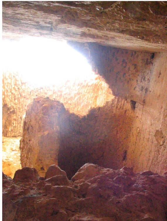
Pese al estado de conservación de las bóvedas, ya que una está muy descompuesta y la otra no podemos ni apreciarla, se observa como el nivel más bajo queda dividido por dos bóvedas apoyadas en un muro diafragmático y el último lo realiza mediante una única bóveda con mayor luz que apoya únicamente en los muros de cerramiento de la torre.
