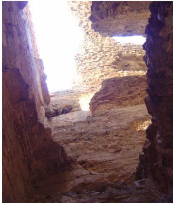
En la parte superior se aprecia la bóveda que cubre el nivel superior, formada por argamasa e hiladas de ladrillo a soga. Su estado es de ruina pudiéndose observar el cielo a través de los huecos dejados por esta.
