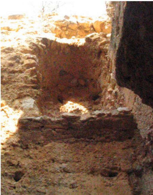
Disminución de la sección en el muro, en forma de nicho sin llegar a perforarlo
