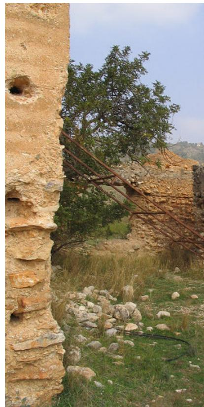
Verticalidad de la base de la torre con ausencia de material en la cimentación y desprendimiento de materiales en su arranque.
