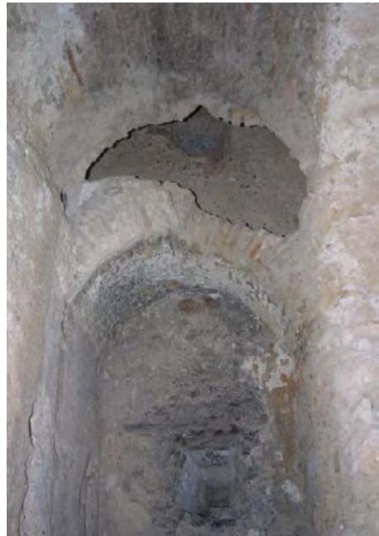
Demolición de parte de la bóveda para que el tramo largo de la escalera pueda seguir su trazado, así vemos como ha sido interrumpida para su construcción.
