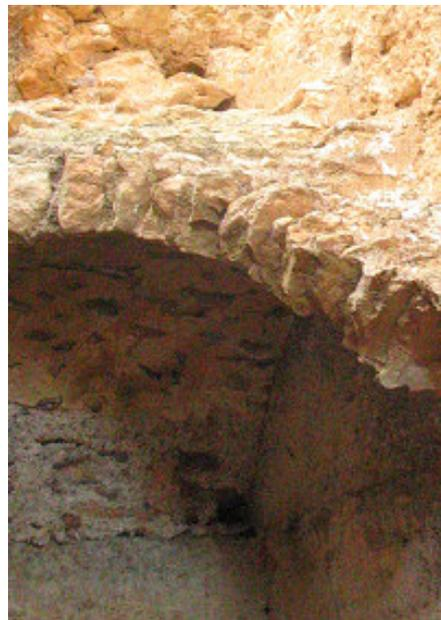
Apoyo de la bóveda con el muro de cerramiento de la torre aprovechando la disminución de sección de los niveles superiores.
