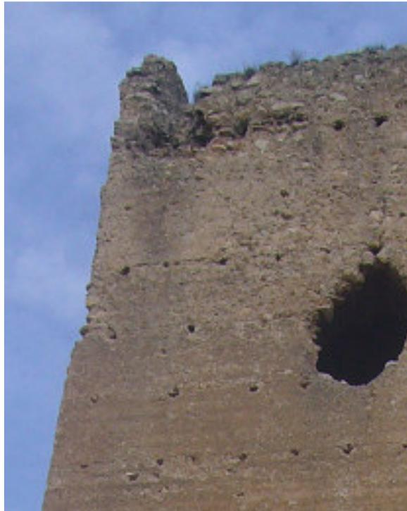
A pesar de la erosión de las almenas todavía se aprecia como en el lateral una de las almenas llega hasta el nivel del suelo para facilitar el acceso a las plataformas voladas para lanzar objetos.
