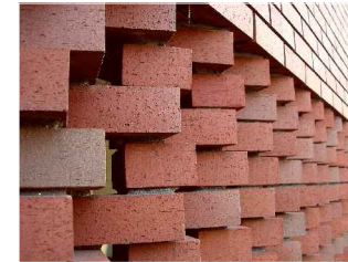
Celosía a base de ladrillos
