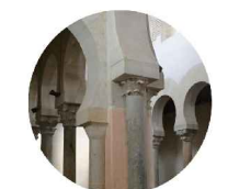
5 reemplazo con pilar y capitel simplificado con material de tono mas claro y reconocible
