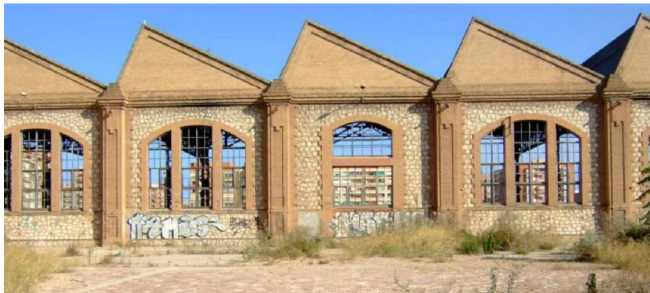
Imagen de la fachada oeste, estado actual, imagen de archivo municipal.
