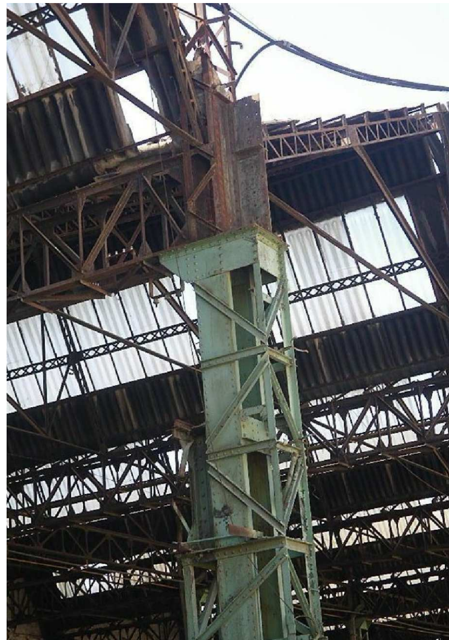
Imagen de la estructura de hierro, estado actual, imagen de archivo municipal.
