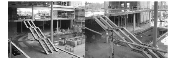
Estructura de escaleras_Sede Caja de Badajoz
