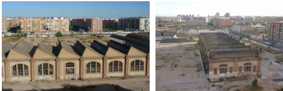
Imágenes aéreas desde edificios colindantes: Izq. C/San Vicente, 272 ; Der. C/ Almudaina, 11.
