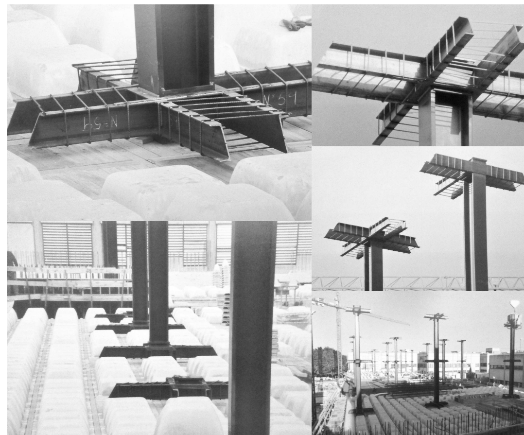
Imágenes de la estructura del edificio 4P del Campus de la UPV
