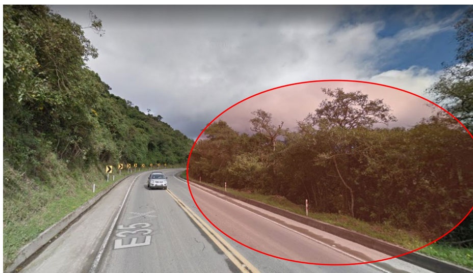
Figura 41. Ejemplo de obstáculos a eliminar para ganar visibilidad.
