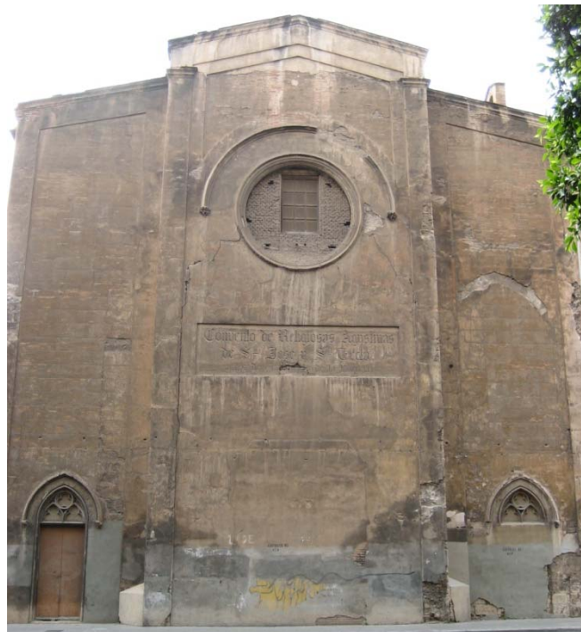
Muro este, recayente a calle San Vicente.
