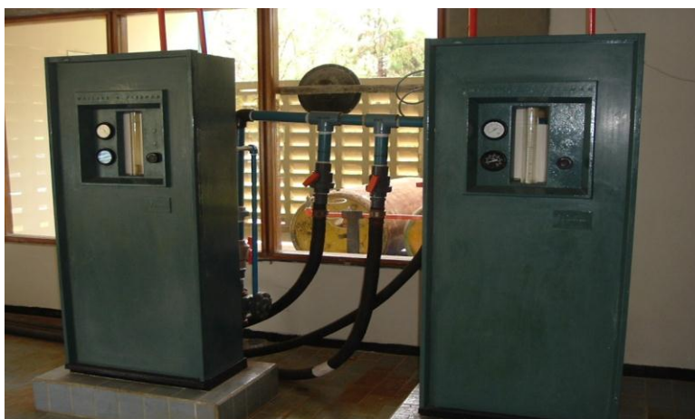
Imagen 2.13. Sistema de cloración de la planta de potabilización Dr. Enrique Bourgöin
