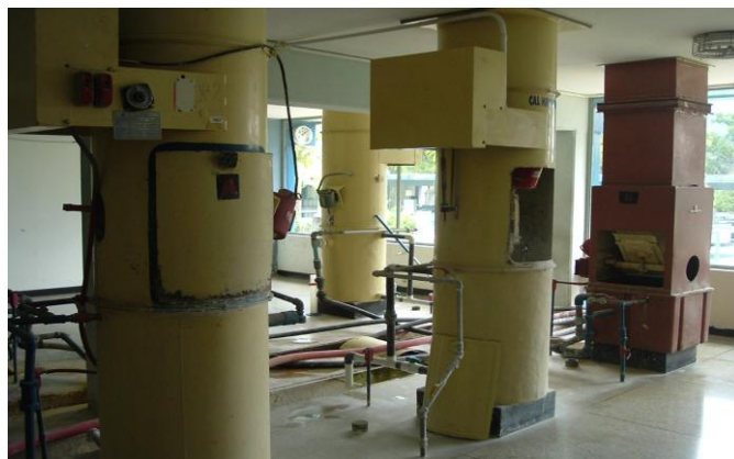
Imagen 2.12. Dosificadores de la planta de potabilización Dr. Enrique Bourgöin
