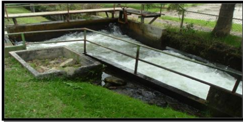
Imagen 2.11. Área de desbaste entrada a planta de potabilización
