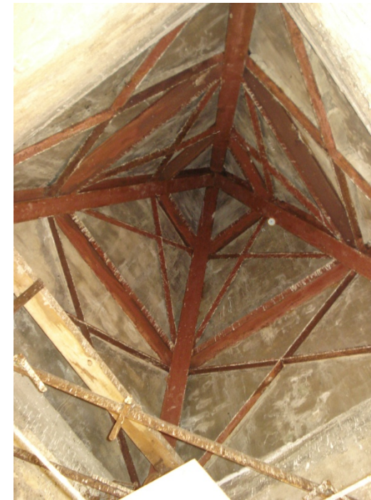
Fotografía del interior del chapitel.
