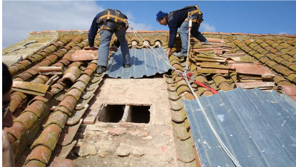
Foto del desmontaje de la cubierta. Se observan los tabiquillos sobre los que descansa la sobrecubierta así como los bardos cerámicos que sirven de apoyo a las tejas.
