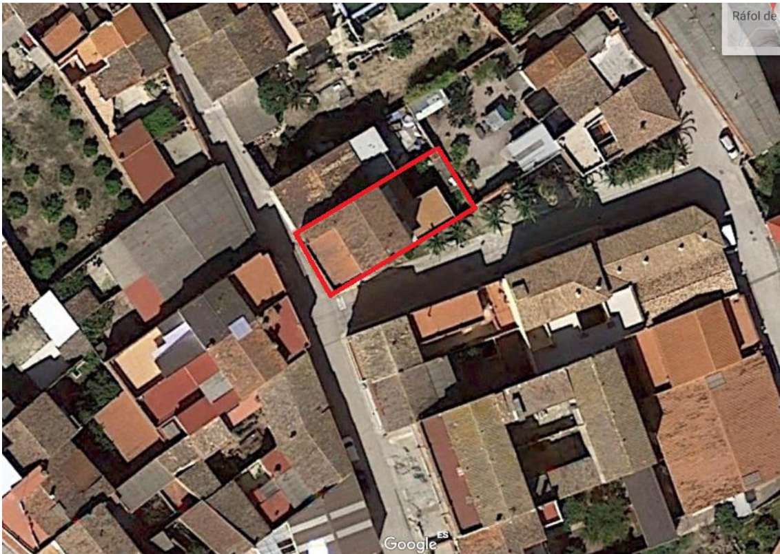
Ilustración 3: Vivienda unifamiliar donde se va a realizar la instalación.
