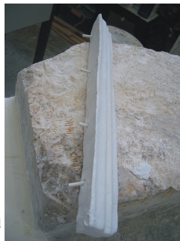
Figura 102. Detalle de la replica de la moldura realizada en el molde de silicona, antes de su unión con pernos de fibra de vidrio.
