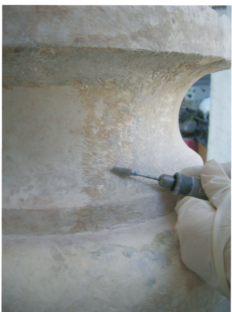
Figura 26. Eliminación con micropercutor de la pátina de la base.
