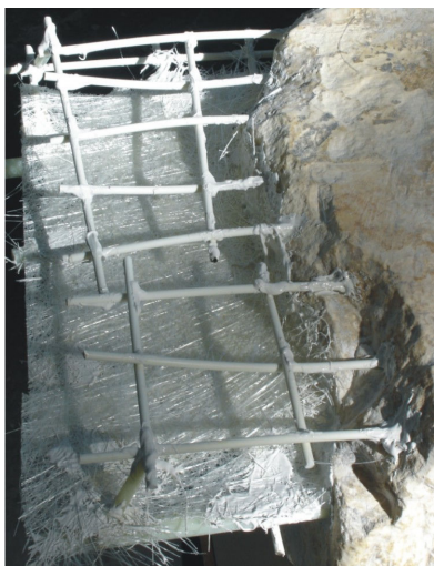
Figura 100. Detalle de la estructura de varillas de fibra de vidrio con la tela de fibra de vidrio, antes de la colocación de la mezcla del mortero.
