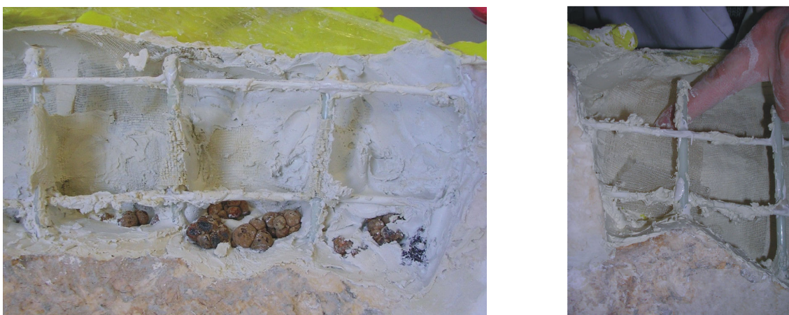
Figuras 69 y 70. Detalle de aplicación de las primeras capas de mortero (ledan) con las bolitas de arlita, mortero petratex para aligerar el peso, y detalle de la colocación de tela de fibra de vidrio para dar más consistencia a la estructura del mortero.
