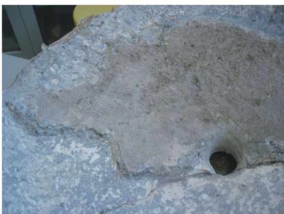
Figura 21. Morteros adheridos a la pila antes de su eliminación Figura 22. Detalle de limpieza con microincisor
