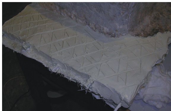
Figura 100. Detalle de la estructura de varillas de fibra de vidrio con la tela de fibra de vidrio, antes de la colocación de la mezcla del mortero.
