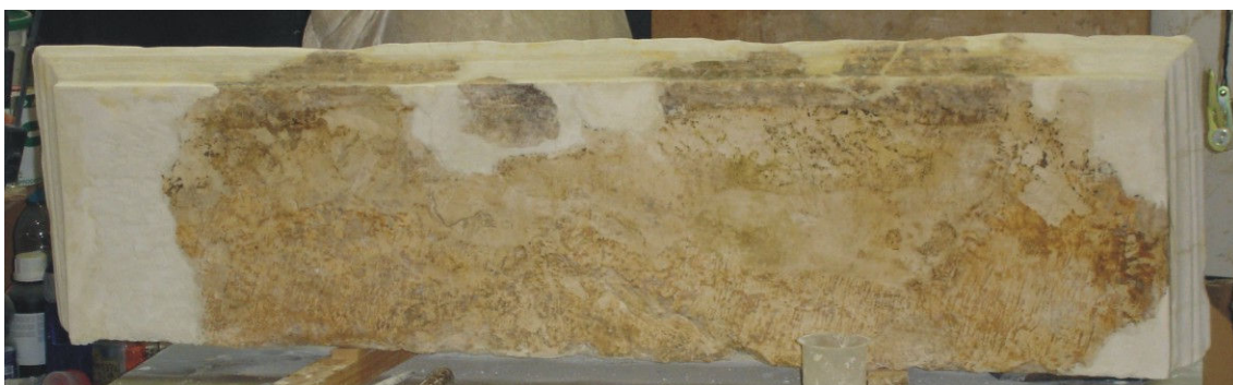
Figura 103. Base de los violines una vez terminada la reconstrucción volumétrica y la adecuación de deterioro final.
