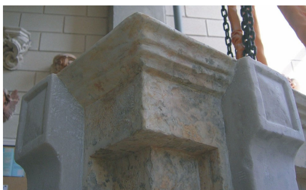
Figura 115. Detalle de la reintegración cromática en una las molduras superiores realizadas con mortero.
