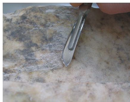
Figura 54. Detalle de la eliminación de manchas mediante bisturí.
