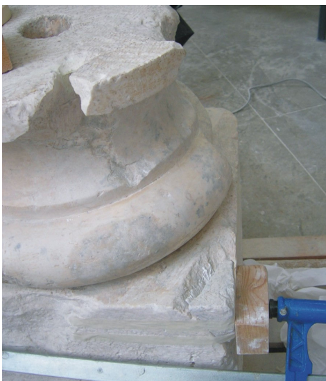
Figura 72. Detalle de adhesión de fragmentos y faltante de la base, antes de la colocación de pernos.
