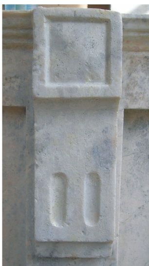
Figura 110. Reintegración de la réplica en resina. Para la reintegración cromática se empleó pintura Maimeri aglutinado con barniz de retoque.
