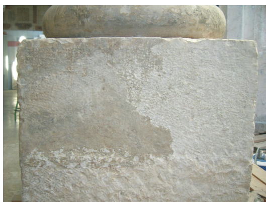
Figuras 27. Limpieza de la base con el micopercutor.
