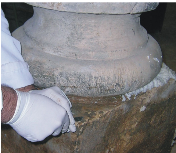
Figura 44. Detalle de la eliminación de los empacos y posterior limpieza con bisturí de las incrustaciones de cementos y tierras adheridas a la base.
