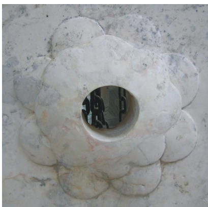
Figuras 112. Detalle de la reintegración cromática final de la flor y parte inferior del frontal.
