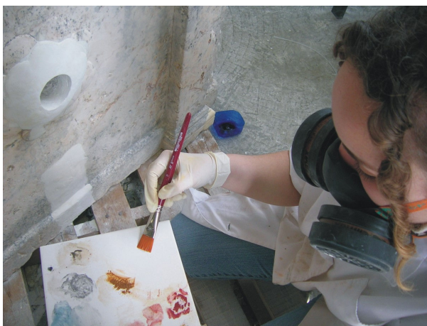
Figura 108. Primera capa de hidrofugante más pigmento.
