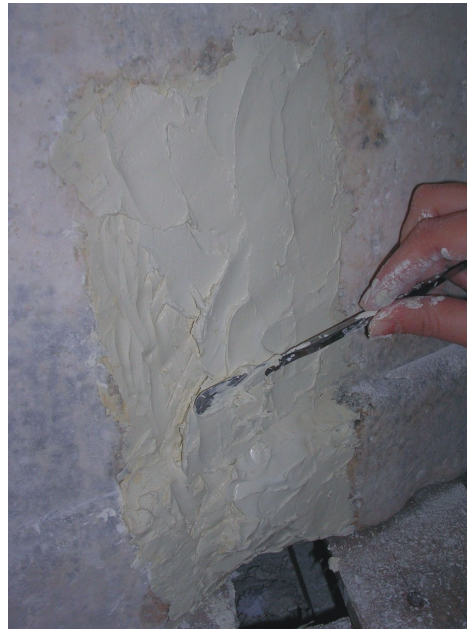
Figura 78. Sellado del hueco con la colocación de pernos.
