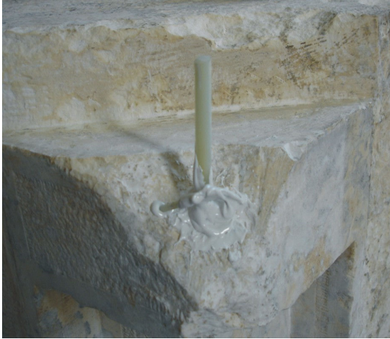
Figura 76. Detalle de la colocación del perno para el anclaje de la cornisa.
