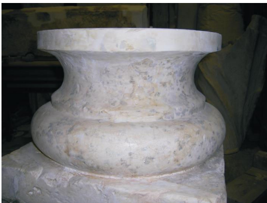
Figura 107. Detalle del resultado final de la reintegración cromática.
