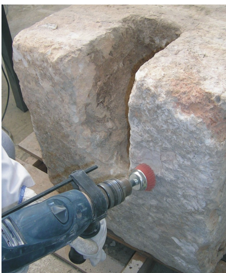
Figura 29 y 30. Limpieza de morteros de cemento y tierra en la parte inferior de la base, con taladro de hilos de fibra y detalle de la misma.
