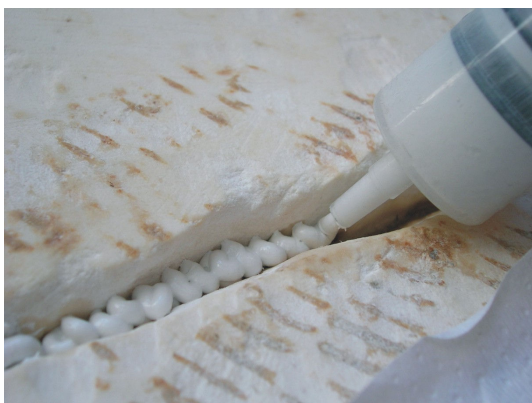
Figura 59. inyección de la resina epoxídica tixotrópica (EPO121) para el encolado de la parte posterior de la pila.
