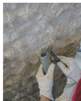
Figuras 32 y 33. Detalles de limpieza con el micropercutor y el microincisor para la limpieza más superficial en los laterales del frontal.
