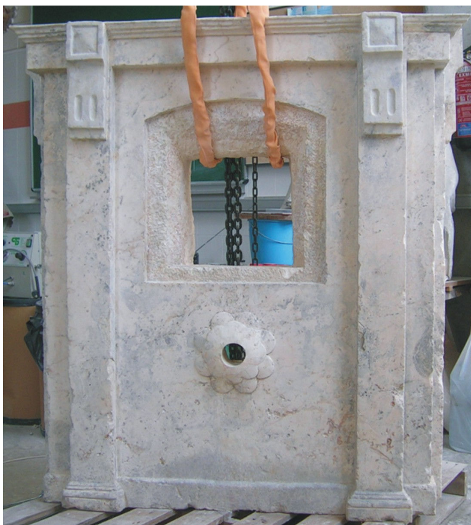
Figura 116. Resultado final de la reintegración cromática del frontal de la fuente.
