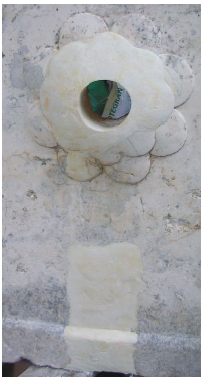
Figura 111. Primera base adecuada al tono original de la piedra en la flor y parte inferior del frontal.
