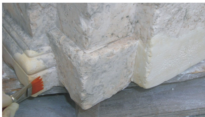
Figura 113. Detalle de la reintegración cromática base.
