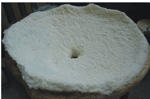
Figuras 42 y 43. Empacos de arbocel en la zona interior e inferior de la pila.
