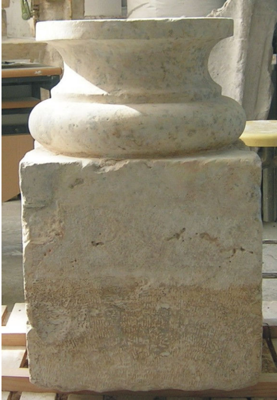
Figura 106. Resultado final de la reintegración cromática en la base de la pila.
