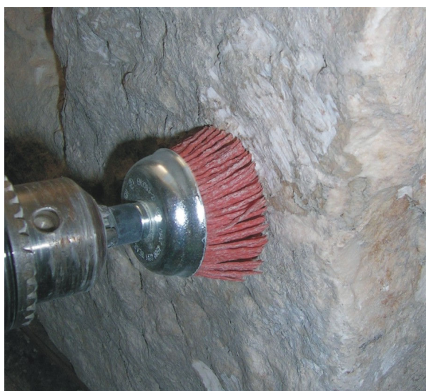
Figura 29 y 30. Limpieza de morteros de cemento y tierra en la parte inferior de la base, con taladro de hilos de fibra y detalle de la misma.
