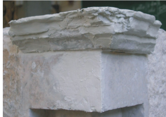
Figura 76. Detalle de la colocación del perno para el anclaje de la cornisa.
