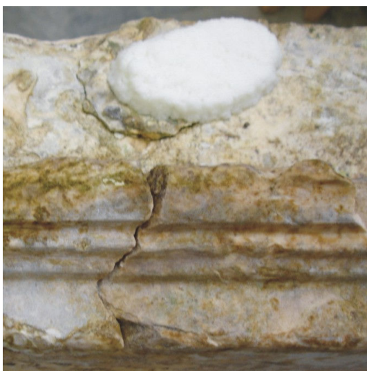
Figura 47. Estado de la base de los violines antes de su restauración.
