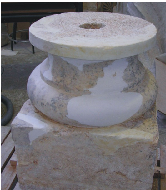
Figura 74. Fase final de los estucos de la base antes de la reintegración cromática
