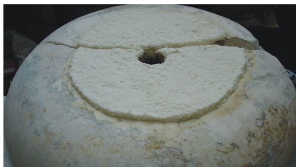
Figuras 42 y 43. Empacos de arbocel en la zona interior e inferior de la pila.
