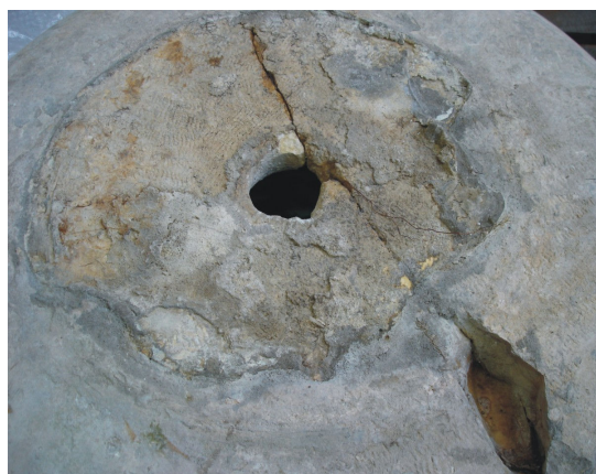
Figura 24. Detalle de la pátina y morteros.
