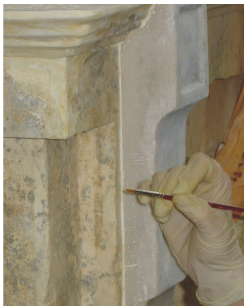
Figura 108. Primera capa de hidrofugante más pigmento.
