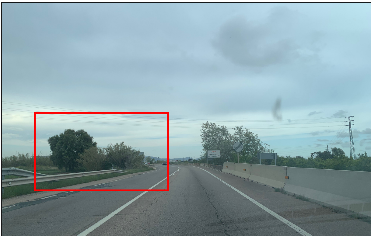
Figura n°21. Fotografía vegetación a desbrozar. Fuente: Elaboración propia
