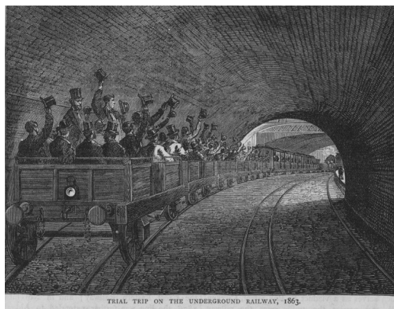
Figura 2: Túnel del metro de Londres, 1863
