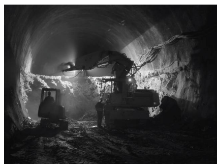
Figura 15: Nuevo Método Austriaco, excavación de bóveda
