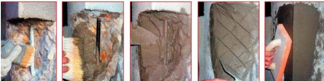
Fig. 153 Aplicación mortero de reparación tixotrópico. Fuente: www.drizoro.es
