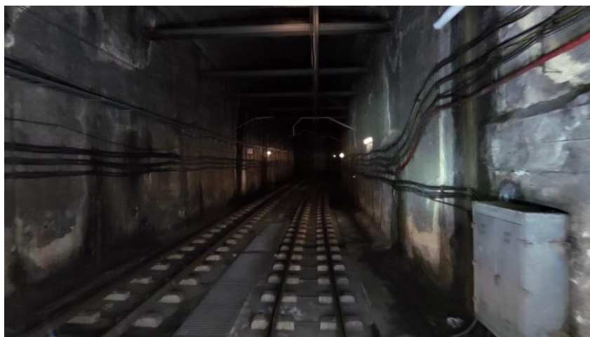
Fig. 135 Salida estación Jesús. Bóveda con estampadores. Fuente: Elaboración propia
