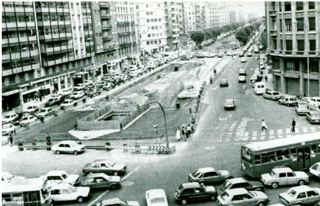
Fig. 6 Obras estación Plaza España confluencia Gran Vía Ramón y Cajal con calle San Vicente. Fuente: Revista OOPP: Suburbanos de Valencia (1985)
