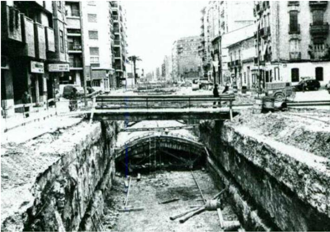
Fig. 7 Obras túnel Empalme – Safranar en la calle San Vicente. Fuente: Revista OOPP: Suburbanos de Valencia (1985)
