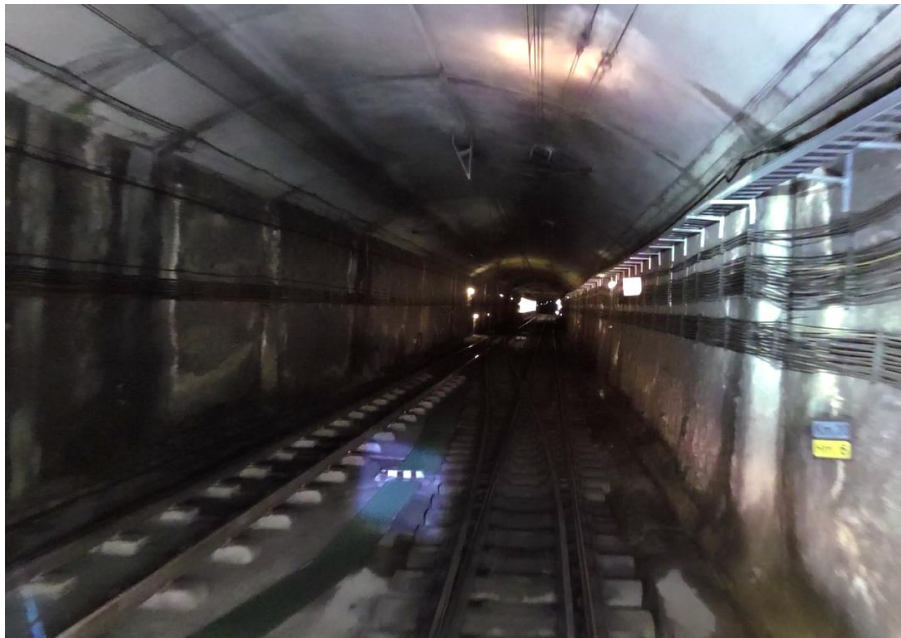
Fig. 136 Ejemplo tramo túnel con bóveda de hormigón sobre traviesas bibloque apoyada en plataforma de hormigón. Fuente: Elaboración propia
