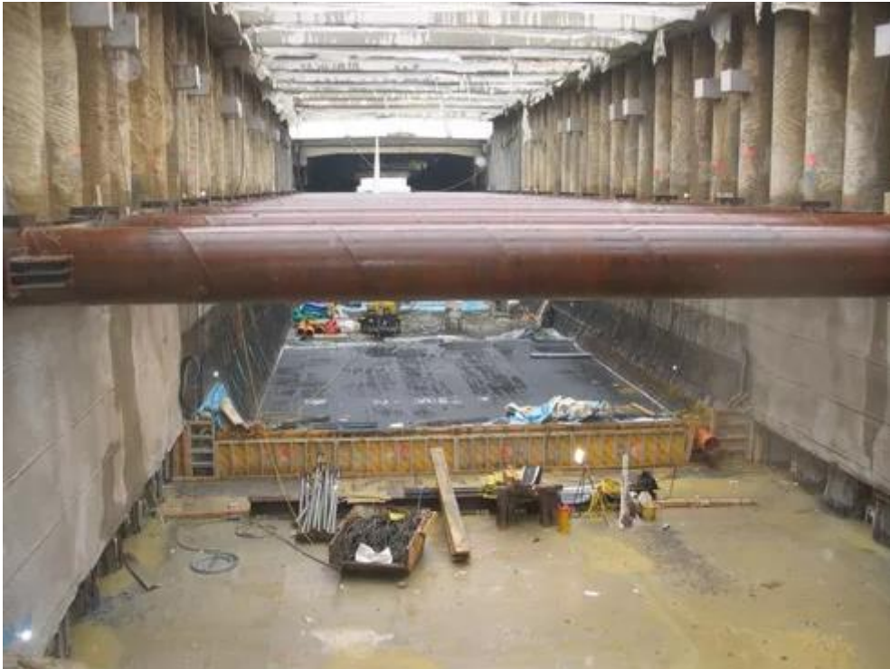
Fig. 124. Método construcción "Cut&Cover". Fuente: www.bgg.at
