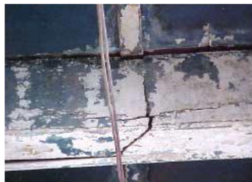
Forjado del edificio de la calle San Ignacio No. 360
