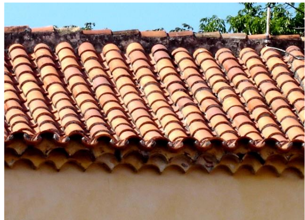
Figura 2.48_ Terminación de alero en forma de tejazoz
