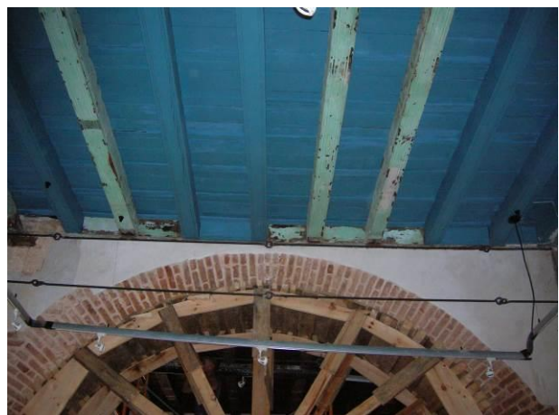
Figuras 4.17 y 4.18_ Colocación de cimbra de madera en arco de medio punto para garantizar la seguridad de las labores de colocación de los tensores, 2009.
