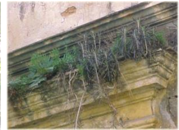
Figura 3.11 (izquierda)_ Ficus crecido en la contraescarpa del Castillo de la Real Fuerza.
