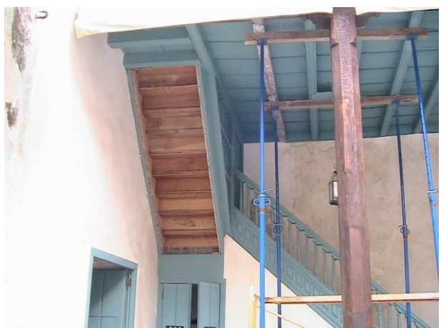
Figura 4.21_ Reparación de la segunda rama de la escalera, 2011.
