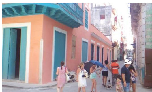
Figuras 4.29 | 4.30 | 4.31_ Fachadas y balcón de la Casa Prat Puig luego de la intervención más reciente, año 2016.
