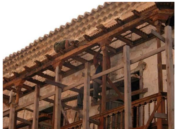
Figuras 4.13 y 4.14_ Intervención en las fachadas y el balcón de la Casa Prat Puig, 2005.
