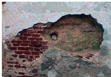
Figura 2.28 (izquierda) _ Muro mixto: Calle Sol entre Aguacate y Compostela. Figura 2.29 (derecha) _ Muro de mampuesto: La Habana Vieja (s/i).
