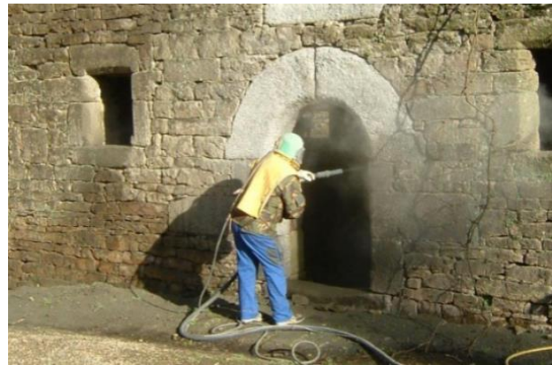
Figura 4.58_ Limpieza por chorreo de abrasivos.
