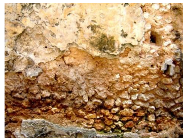
Figura 2.28 (izquierda) _ Muro mixto: Calle Sol entre Aguacate y Compostela. Figura 2.29 (derecha) _ Muro de mampuesto: La Habana Vieja (s/i).
