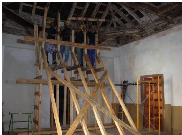
Figura 4.20_ Intentos fallidos de sustitución de elementos podridos o pandeados en el alfarje del salón esquinero, 2011.
