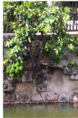
Figura 3.11 (izquierda)_ Ficus crecido en la contraescarpa del Castillo de la Real Fuerza.
