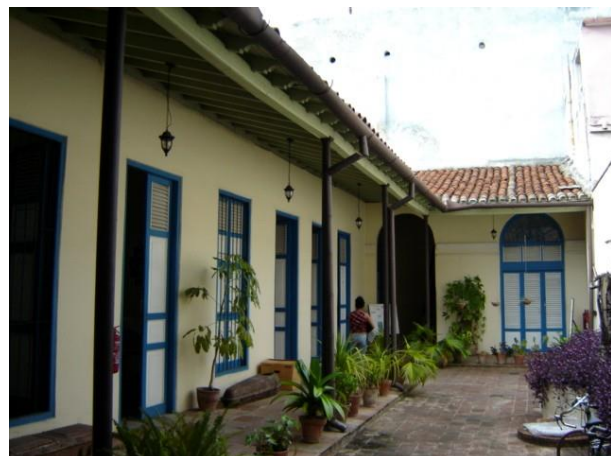
Figura 2.49_ Recolección de aguas con bajantes y canales pluviales
