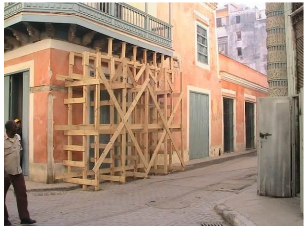
Figura 4.19_ Reparación del balcón de la Casa Prat Puig, 2011.
