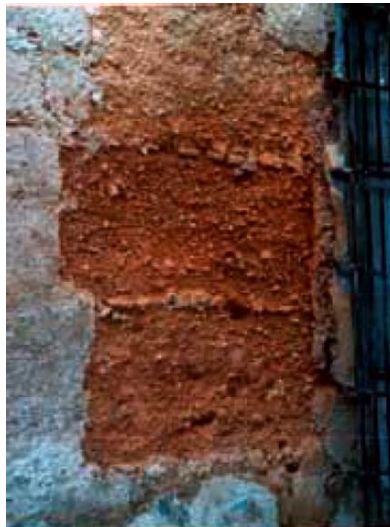
Figura 2.26 (izquierda) _ Muro de tapia con verdugadas de ladrillos: Empedrado entre Aguiar y Cuba Figura 2.27 (derecha) _ Muro de tapia: La Habana Vieja (s/i)
