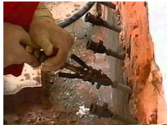
Figura 4.57_ Barrera química mediante la inyección de Maxclear Injection
