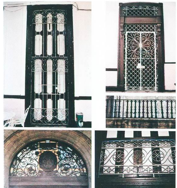
Figura 2.71_ Carpintería y rejería de la Casa de la Marquesa de Villalba (S. XIX).
