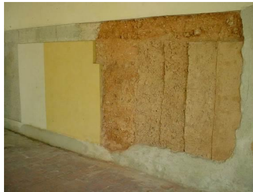
Figuras 2.25 Muro de tapial descubierto durante la ejecución de obras de restauración. La Habana Vieja (s/i).
