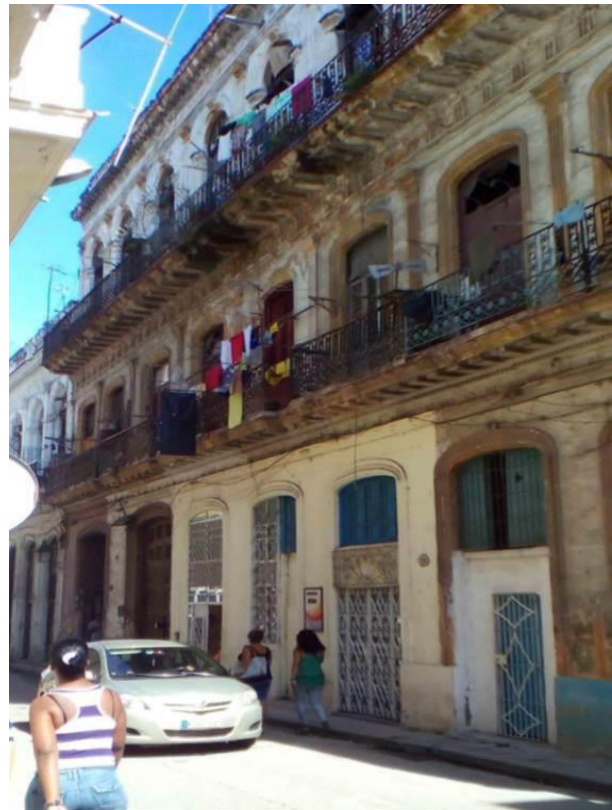
Figura 3.29_ Fachada de la Calle Cuba No. 519. Múltiples lesiones de tipo superficial y modificaciones antrópicas.
