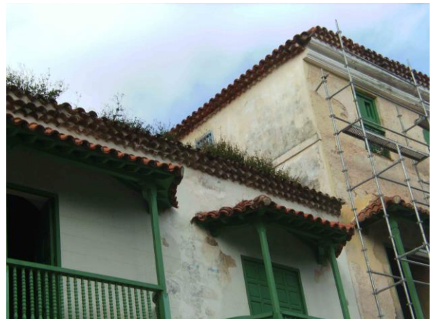
Figura 3.31_ Crecimiento vegetal en cubierta inclinada con cobertura de tejas criollas. Tacón No. 4.
