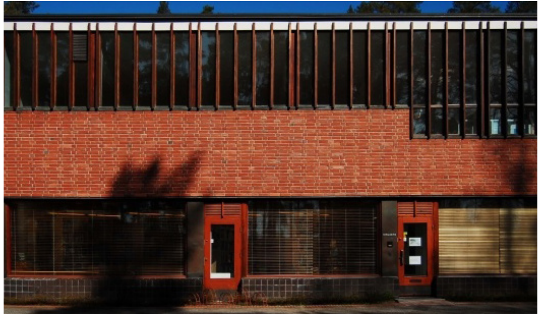
IMAGEN 64: Biblioteca del Ayuntamiento de Säynätsalo, Alvar Aalto Fuente: Foto de Marcio Cotrim. http://vitruvius.com.br/revistas/read/arquitectos/11.125/3635
