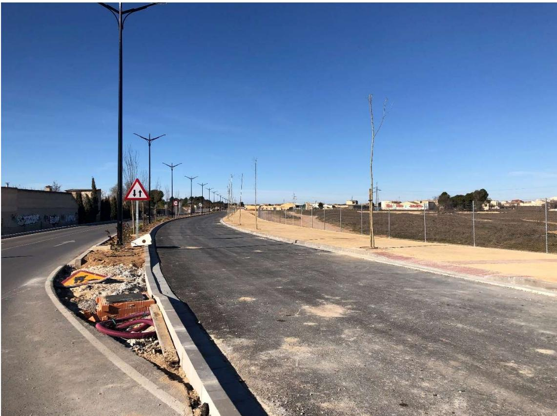
*Figura 44: Finalización del paseo terrizo. A falta de la capa de rodadura y entronques en la calzada principal*
