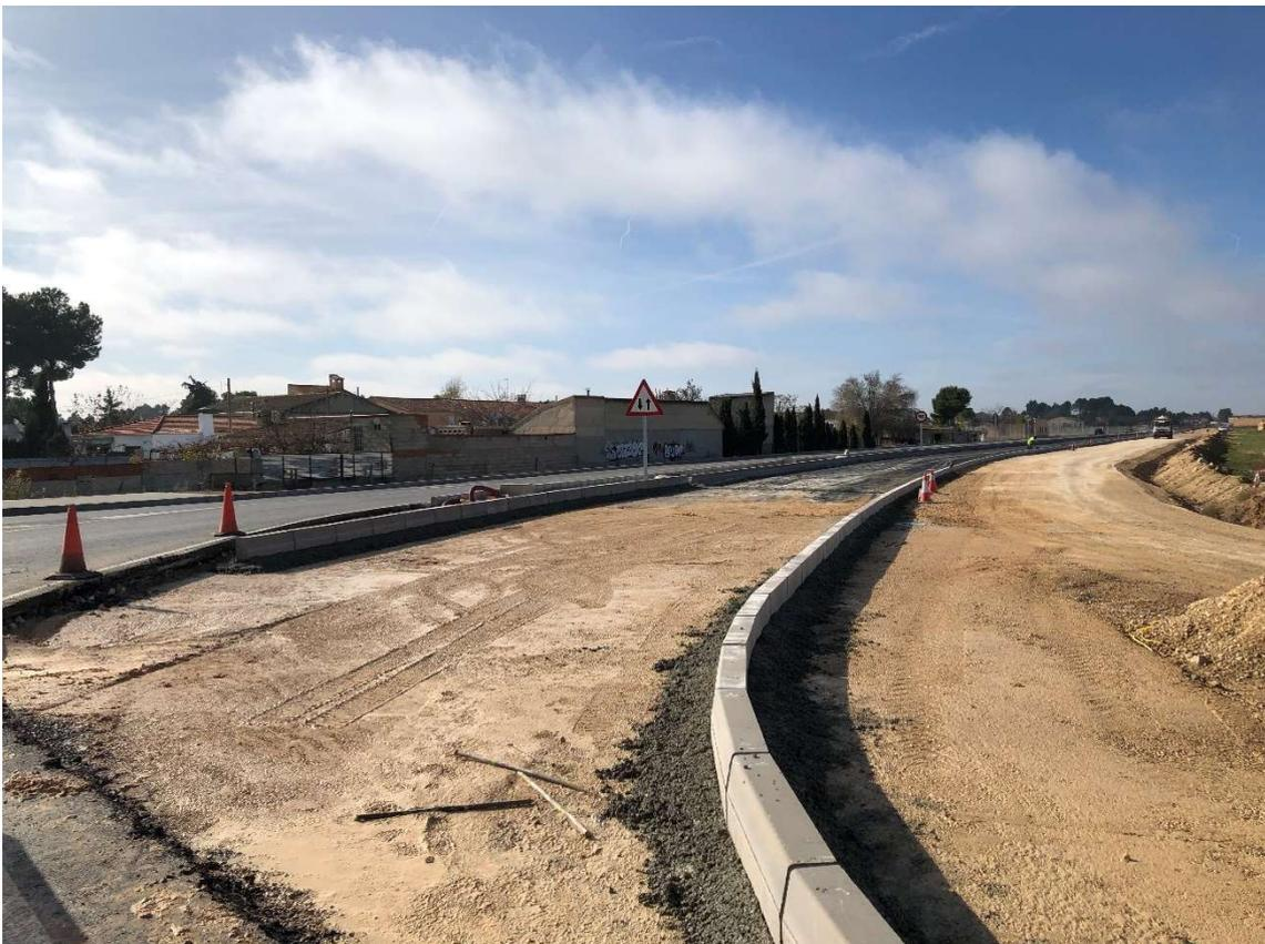
*Figura 42: Finalización de trabajos complementarios y aportación de materiales granulares.*
