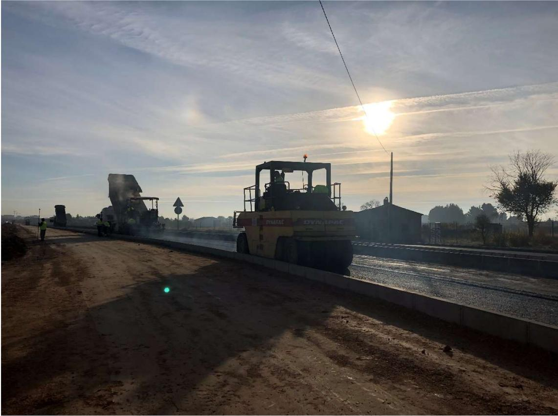
*Figura 43: Trabajos de extendido y compactación de las mezclas bituminosas*
