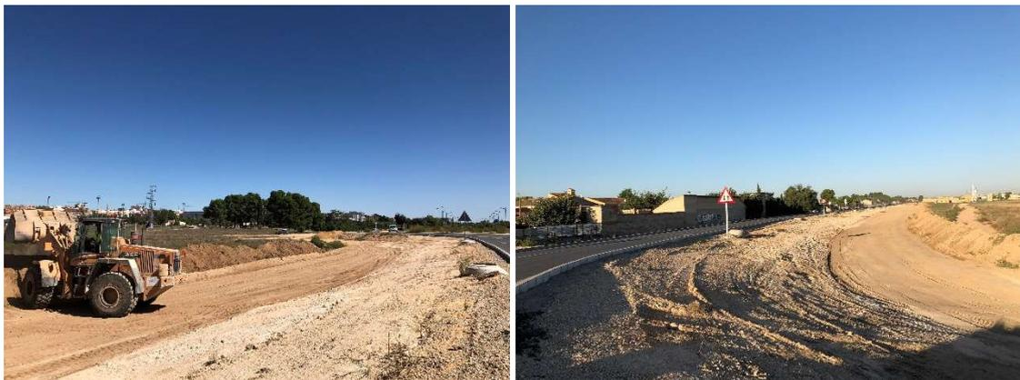
*Figura 40: Comienzo de los trabajos de desbroce y excavación*
