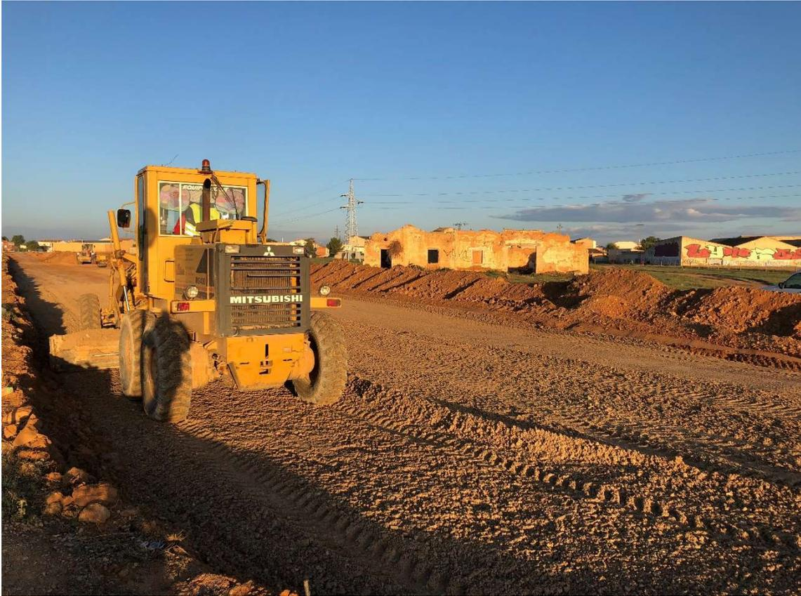
*Figura 41: Trabajos de extendido de materiales*
