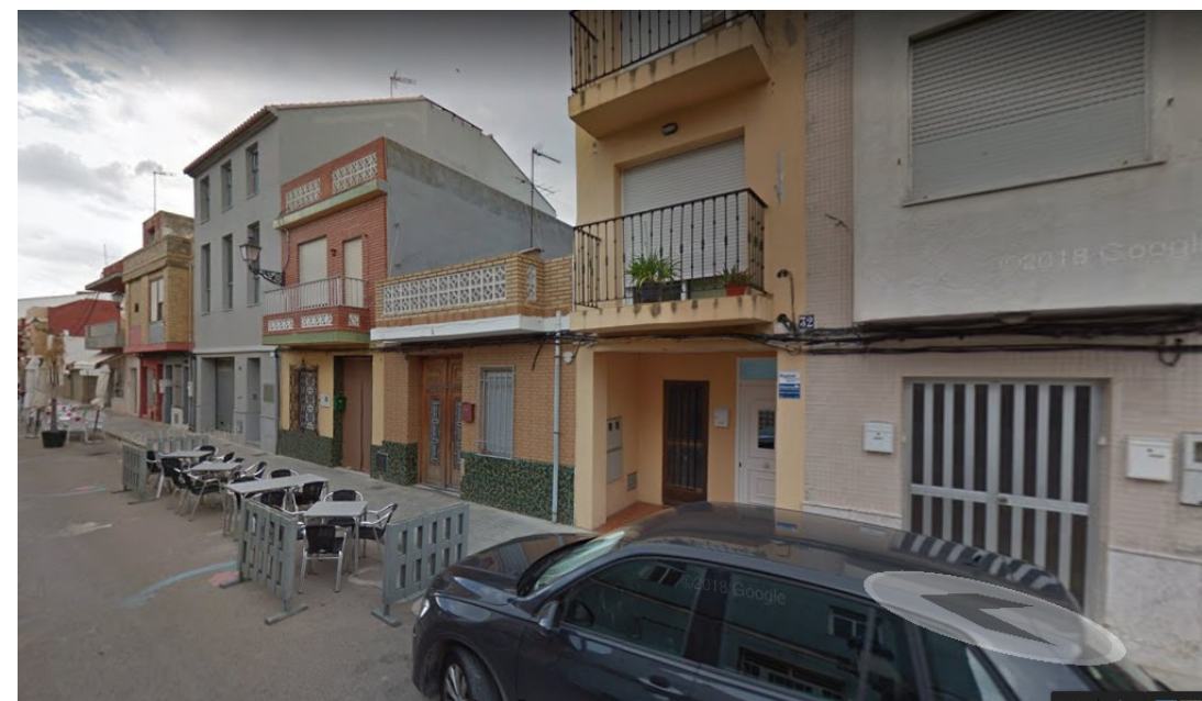
Fig 8. Casa de pueblo coexistiendo con viviendas en dos alturas
