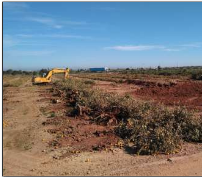
Figura 4. Eliminación de los muretes de obra que conforman el bancal. Fuente: Propia
