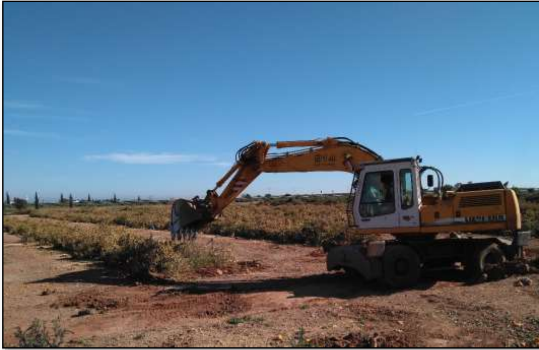
Figura 2. Apilado de leña y destocoñado de los árboles mediante una retroexcavadora. Fuente: Propia
