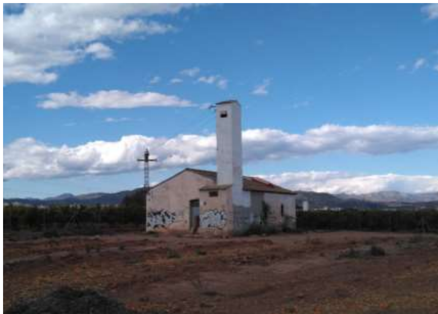
Ilustración 2. Edificación secundaria de la explotación. Fuente: Propia
