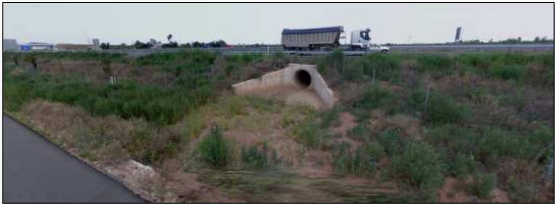
Figura 8. Colector que recoge el agua de la lluvia procedente de la finca. Fuente: Propia
