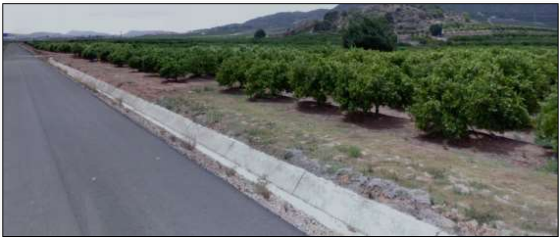
Figura 7. Cuneta que bordea la parte baja de la finca. Fuente: Propia
