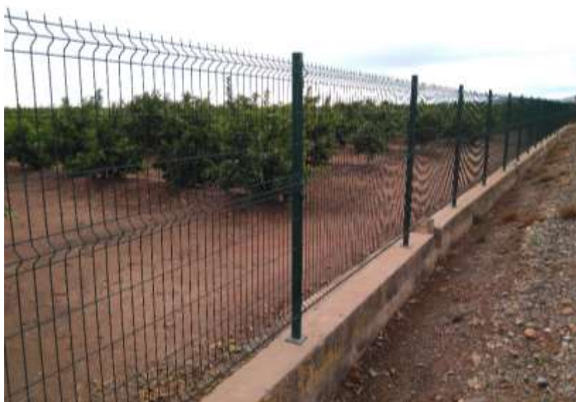
Figura 15. Valla modelo Nylofor 3M instalada en otras fincas en propiedad. Fuente: Propia
