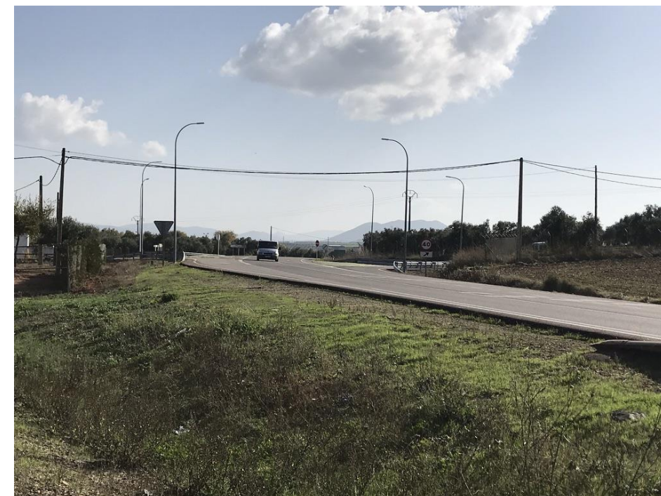
Figura 31. Llegada en curva al cayado que da acceso a Torre de Miguel Sesmero desde Almendral. Vista desde el final del paseo peatonal que sí se integra con la zona urbana de Torre de Miguel Sesmero. Fuente: Elaboración propia in situ.
