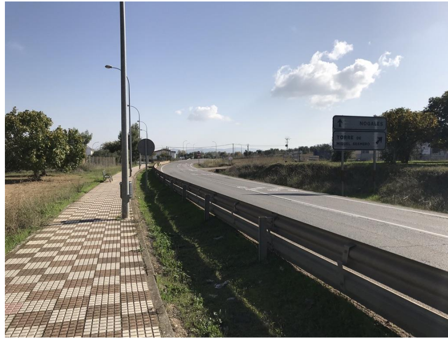
Figura 8. Llegada a Torre de Miguel Sesmero desde la EX-105, con el cruce del tendido eléctrico proveniente de la piscina municipal al fondo.
