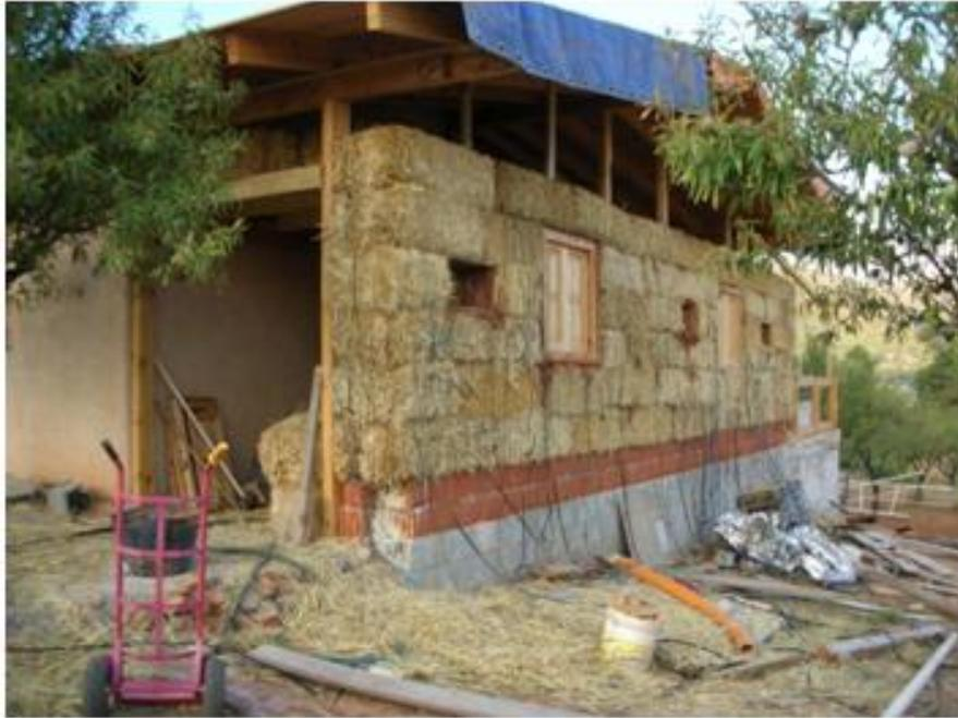
Figura 8.10 Construcción ecológica. Casas de paja (después)
