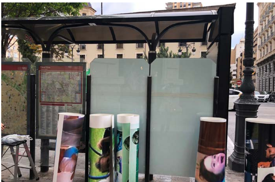
Fig. 99. Instantes antes del montaje en la marquesina, con los materiales preparados.
