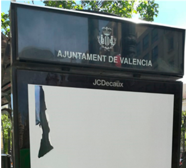
Fig. 102. Estado de la intervención en la marquesina a las 16:00h del mismo día de montaje, parte exterior.
