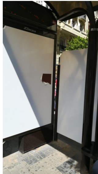
Fig. 103. Estado de la intervención en la marquesina a las 16:00h del mismo día de montaje, parte interior.
