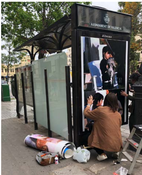
Fig. 100. Montaje de la parte exterior de la marquesina.
