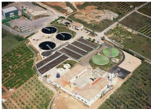
Figura 25. Vista aérea de la EDAR Denia-Ondara-Pedreguer
