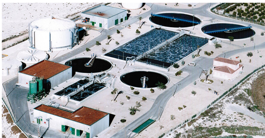
Figura 26. Vistas aérea de la EDAR Molina del Segura
