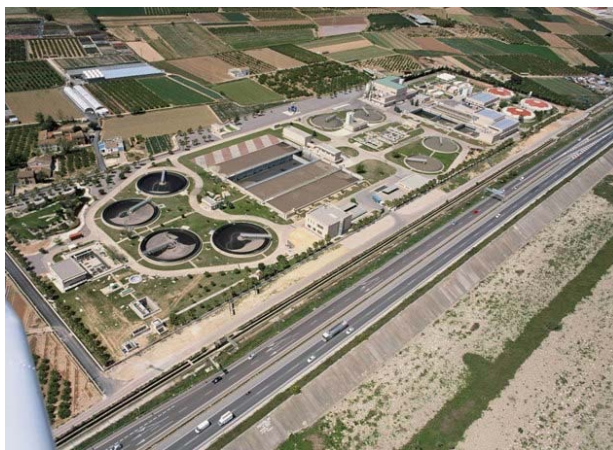
Figura 22. Vista aérea de la EDAR Quart-Benàger
