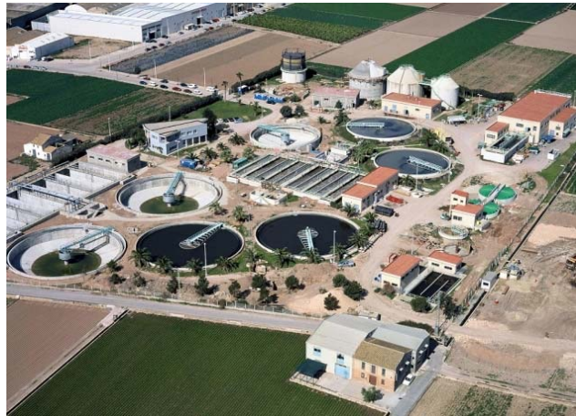
Figura 24. Vista aérea de la EDAR Carraixet
