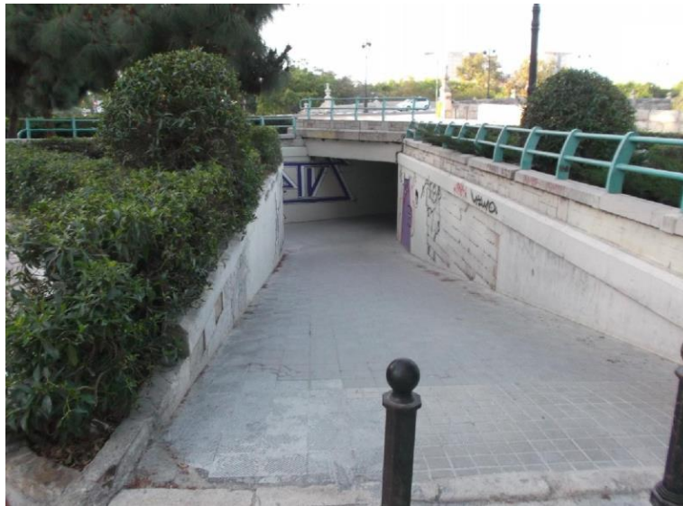
Figura 50 - Paso peatonal inferior
