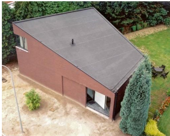
Figura 39. Cubierta a "una agua" (Rollgum, 2016)
