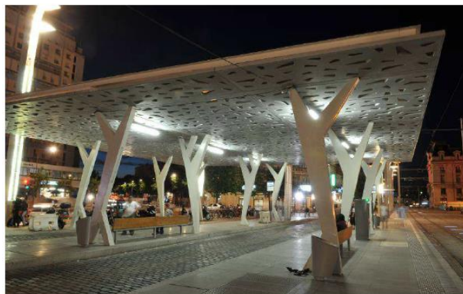
Figura 25. Estación Saint-Jean, Francia (AFGC, 2013)
