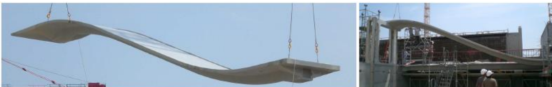
Figura 16. Placa fina pretensada de UHPFRC para cubierta de piscina (AFGC, 2013)
