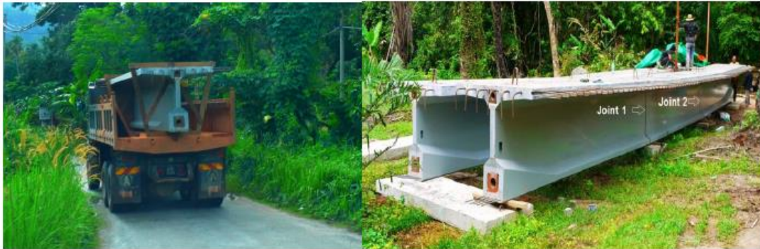
Figura 18. Camión de 10 ruedas que transporta un segmento de viga de UHPFRC de 6m de largo (izquierda); segmentos de vigas alineados listos para el postensado (derecha), (Lei, Nematollahi, Mohamed, Gopal, & Yee, 2012)
