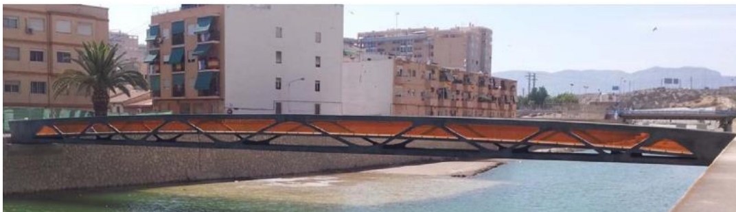
Figura 19. Pasarela de HMAR sobre el Barranco de las Ovejas (Serna, y otros, 2014)
