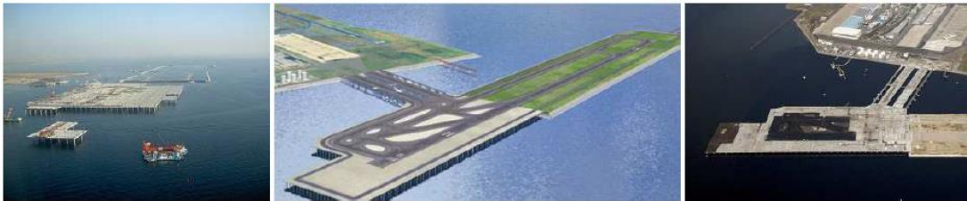
Figura 15. Pista del aeropuerto Haneda en Japón en UHPFRC (AFGC, 2013)
