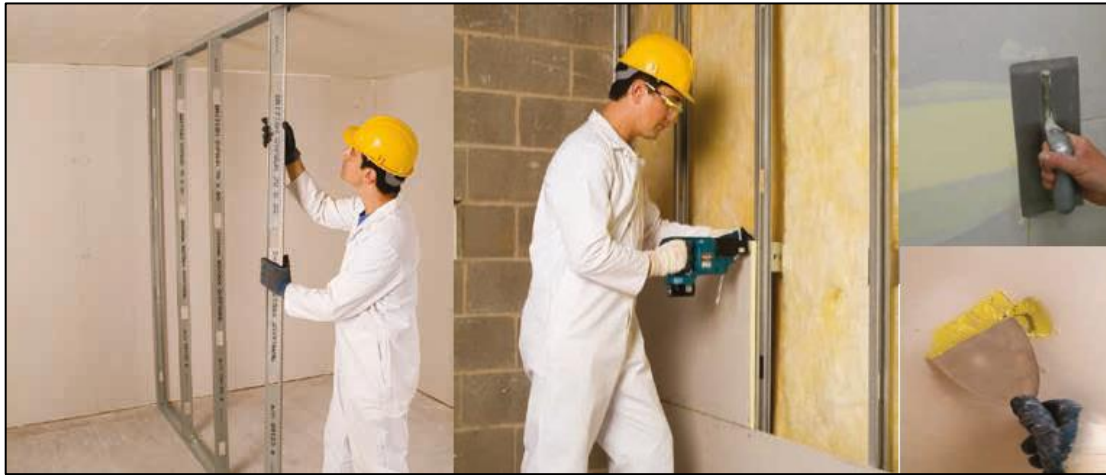
Figura 21. Proceso instalación Placo® X-Ray Protection (Placo Saint-Gobain, 2018).
