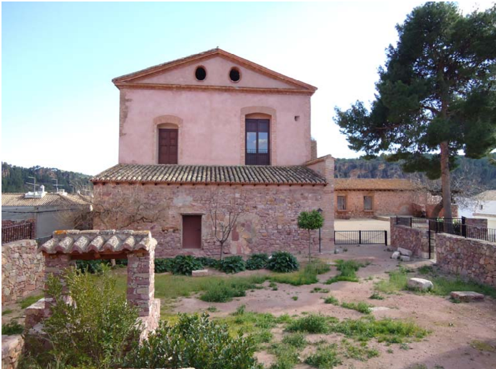
Fachada norte edificio principal
