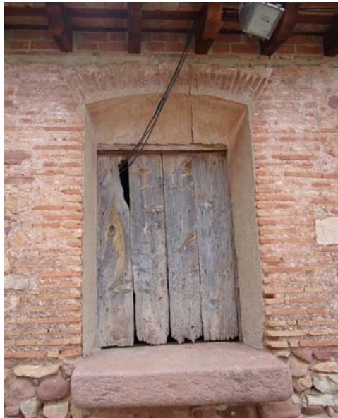
Formación de huecos con ladrillos
