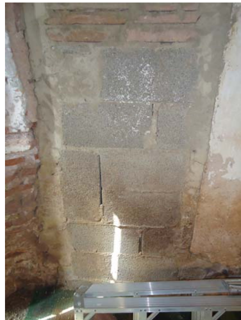
Cegado de hueco
