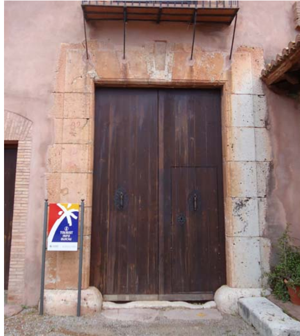
Hueco acceso edificio principal con sillería almohadillada
