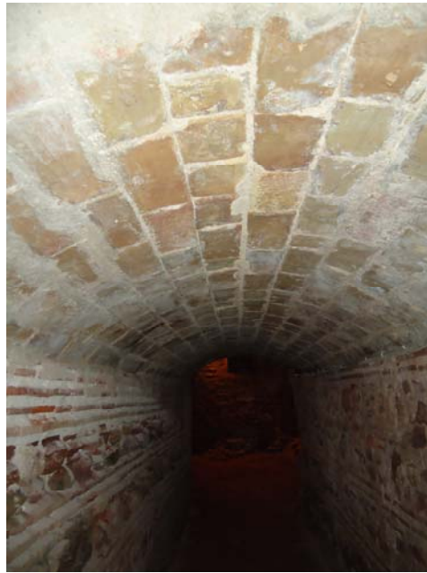
Bóveda de cañón corrido en acceso a bodega
