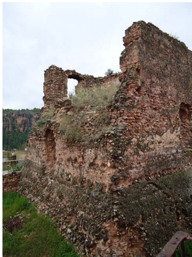
Fachadas torre Pardines
