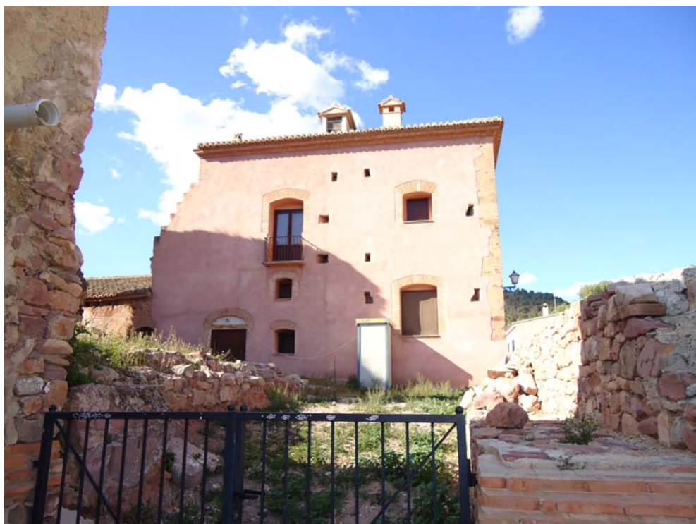
Fachada sur edificio principal
