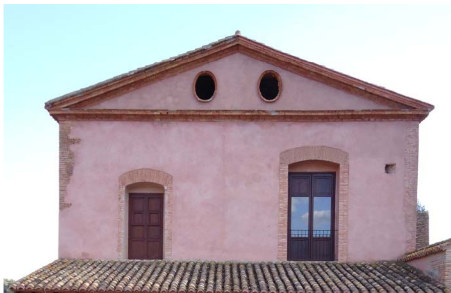
Huecos ovalados para ventilación
