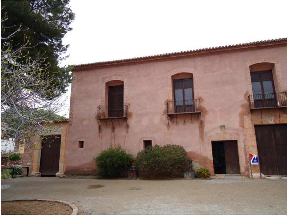
Fachada sur edificio principal
