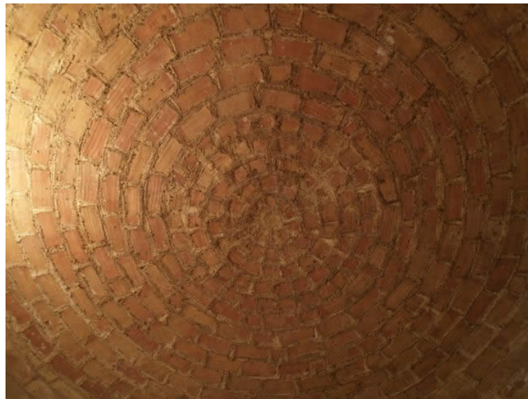
Bóveda plana en bodega
