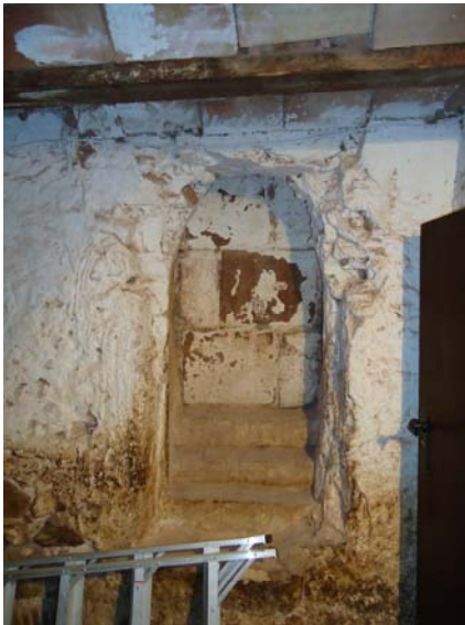
Hueco de acceso a los lagares cegado
