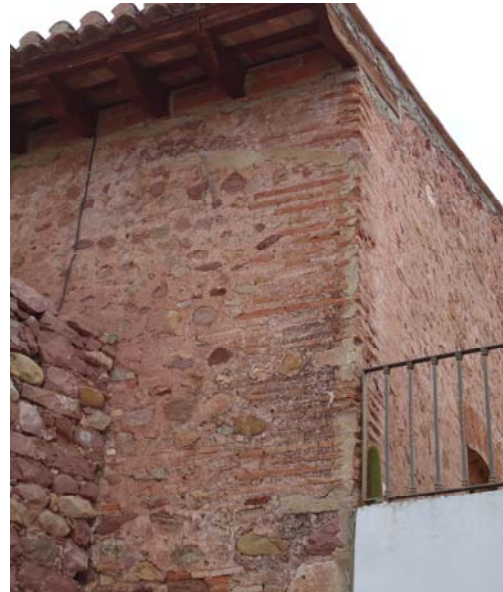
Esquina de fachada con ladrillos
