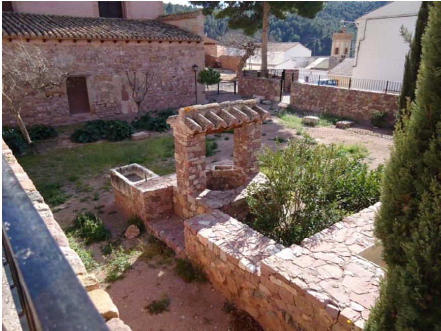
Vista patio delantero con el pozo
