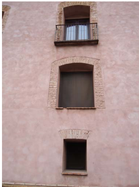
Vista arcos escarzanos empleados
