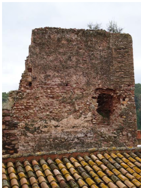
Esquina de la torre reforzada con ladrillos
