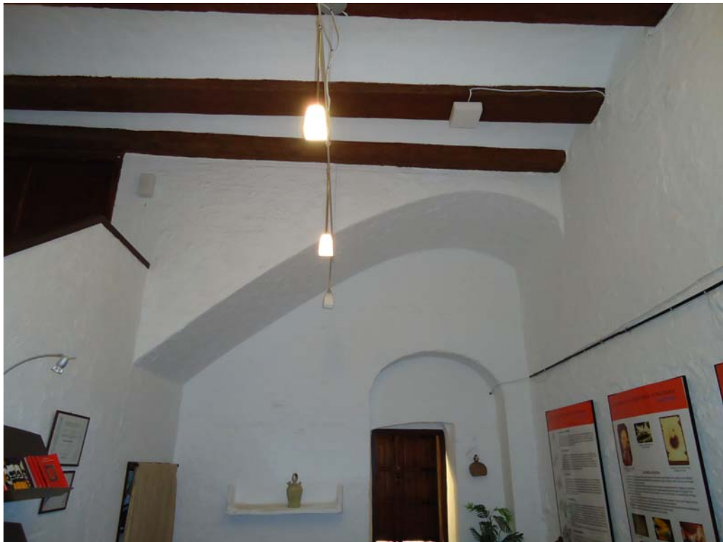
Escalera acceso planta primera
