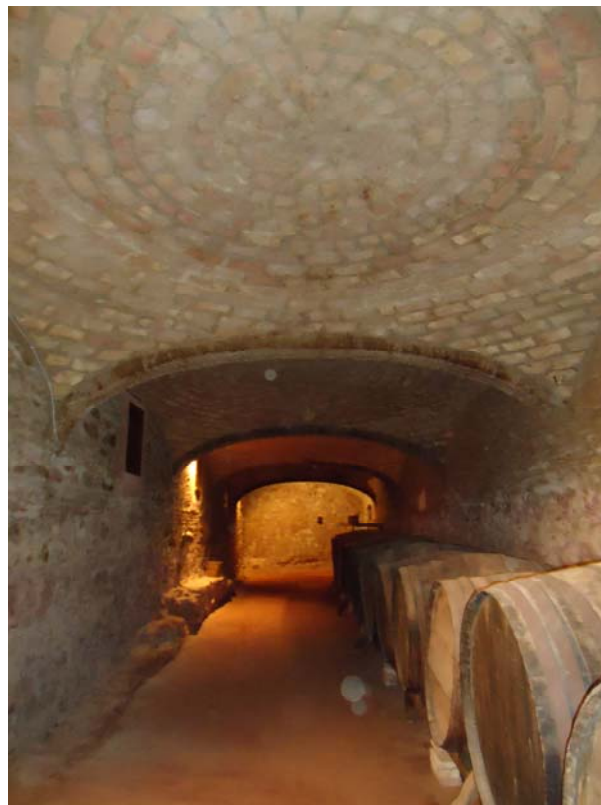
Vista arcos carpaneles en bodega
