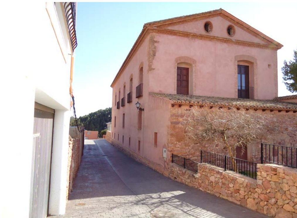
Fachada este edificio principal
