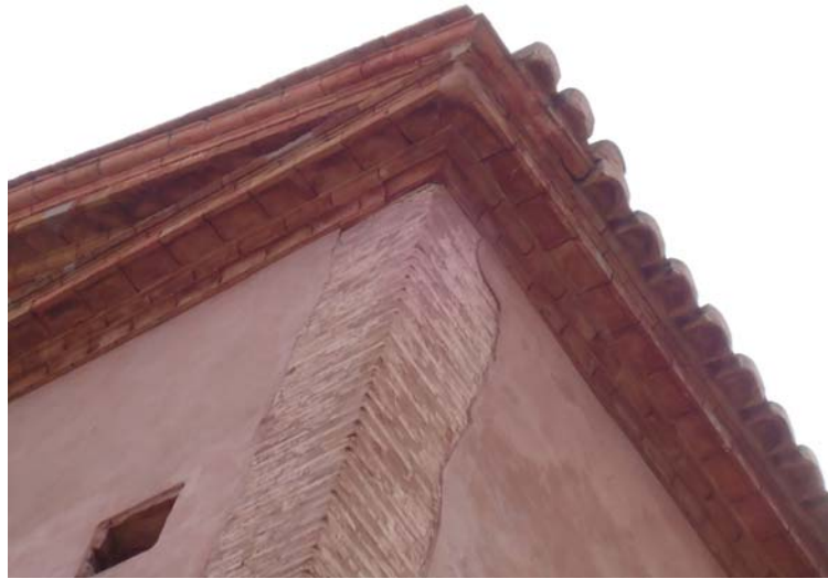
Detalle alero fachada principal
