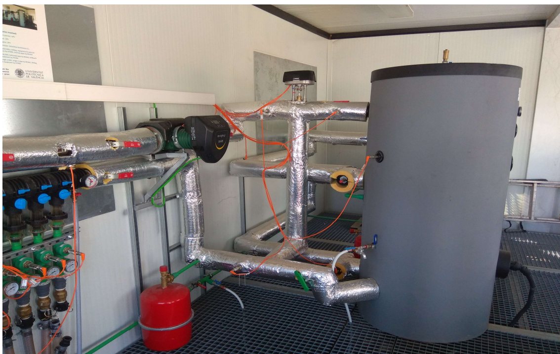
Figura 4 - Instalación del Test Site
