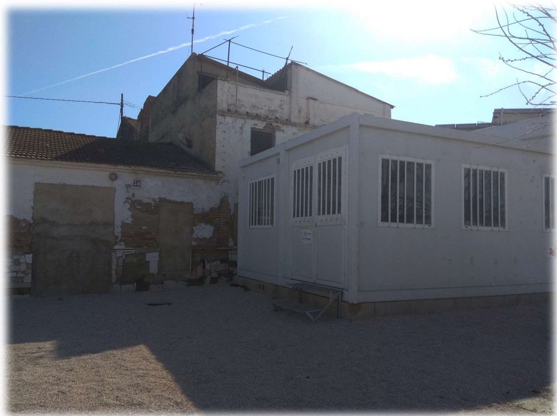
Figura 2 - Vista del Test Site (Exterior)
