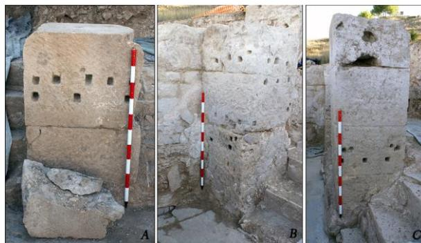
**Figura 13:** Pilares de sillería insertos en el tramo escalonado: A) Pilar central derecho; B) Pilar central izquierdo; C) Pilar del extremo norte. Los bloques que los conforman presentan marcas de fijación de los elementos de revestimiento: placas marmóreas y cornisas de pequeño formato.
