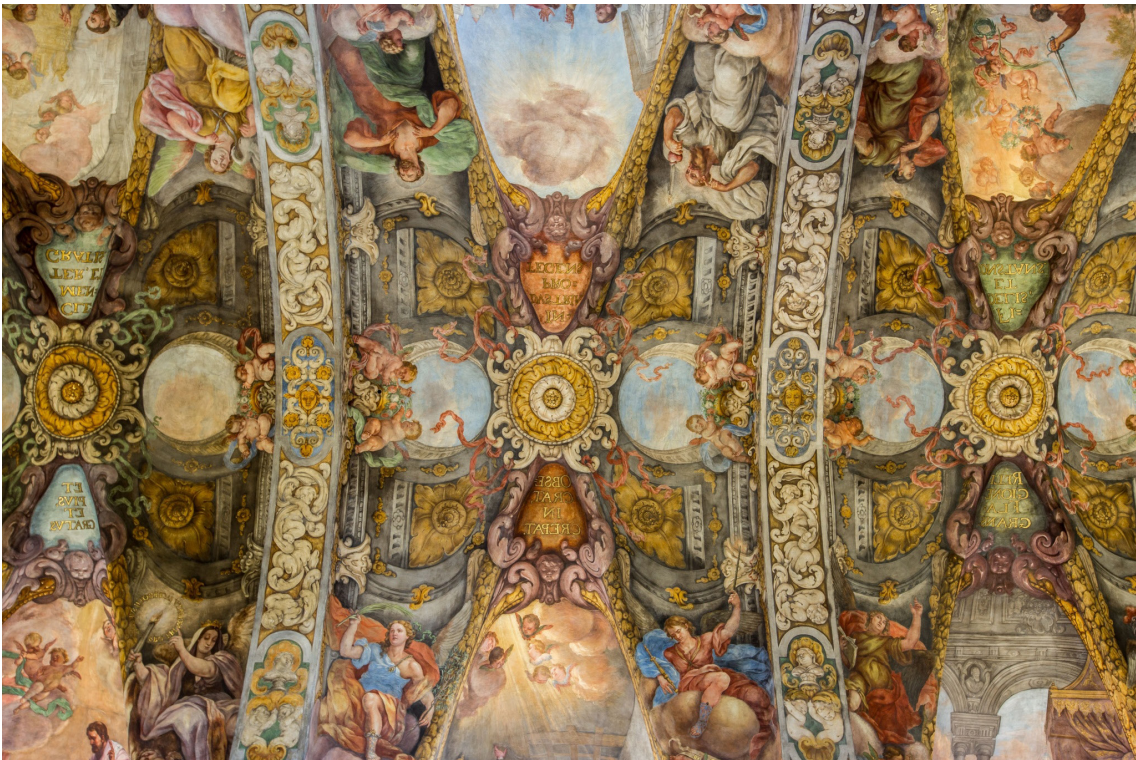
Figura 4: Imagen parcial de la bóveda de la Iglesia Parroquial de San Nicolás Obispo y San Pedro Mártir de Valencia después de la última restauración realizada por el equipo del IRP-UPV.
