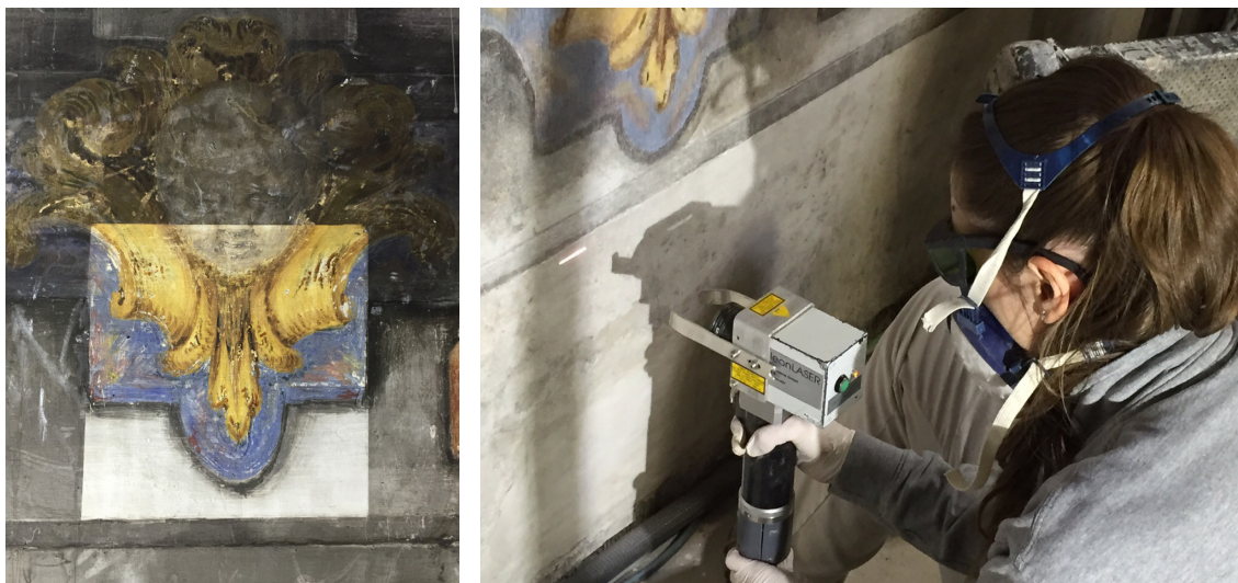
Figuras 19 y 20: Empleo de la técnica láser en la limpieza de ciertas zonas de la Iglesia de San Nicolás de Valencia.
