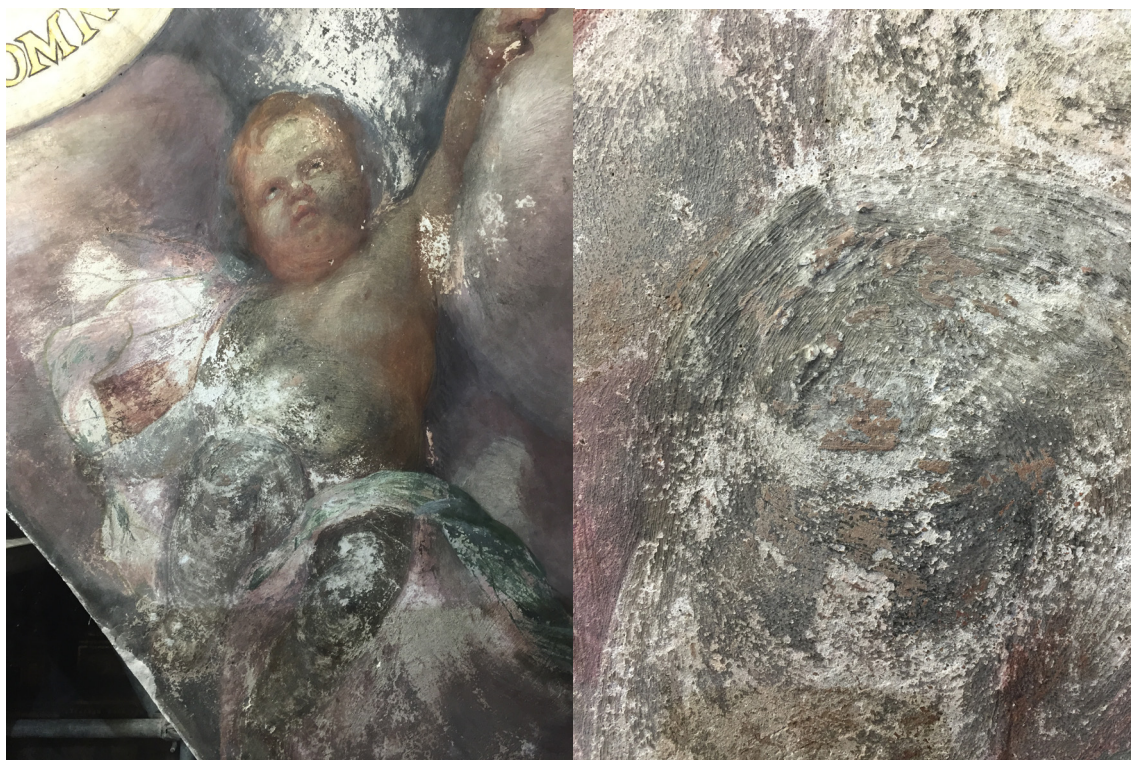
Figuras 7 y 8: Detalle del deterioro causado por la humedad. Se observa pérdida y pulverulencia de la película pictórica. La zona dañada corresponde a repintes en mal estado realizados en intervenciones antiguas. Fotografía tomada durante la restauración de la Iglesia de San Nicolás de Valencia.
