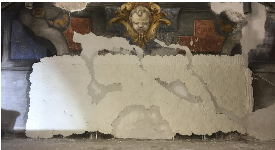
Figura 23: Empaco de fibras de celulosa impregnadas con una solución de carbonato de amonio.
