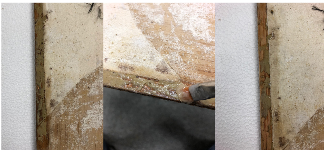
Figuras 272, 273 y 274: Antes, durante y después del testado de la mezcla 4D.
