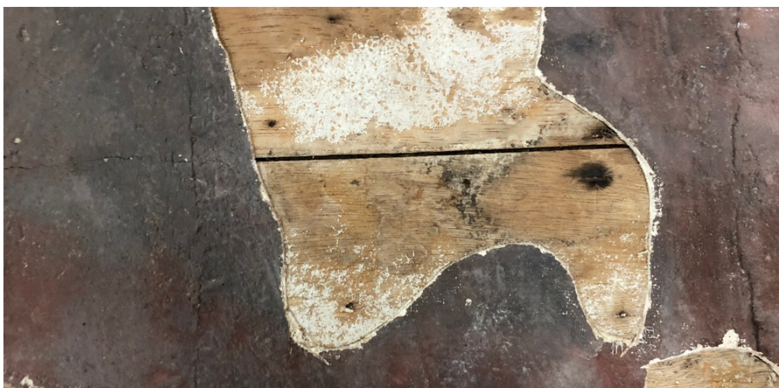
Figura 230: Zona perimetral de los paneles antes de probar las mezclas C, D, G y H.
