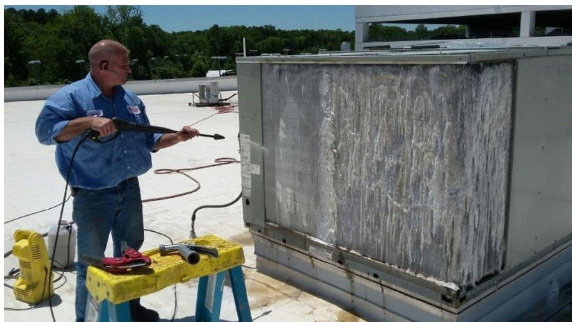
ILUSTRACIÓN 54-CONDENSADOR SUCIO NO EVACUA CALOR ADECUADAMENTE
