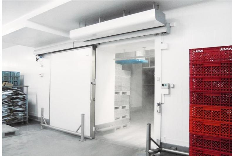
ILUSTRACIÓN 55-CORTINA DE AIRE EN ENTRADA A CÁMARA FRIGORÍFICA – FUENTE:FRICO
