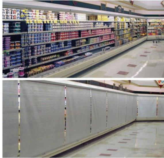
ILUSTRACIÓN 52-TAPADO NOCTURNO DE ARMARIOS REFRIGERADORES – FUENTE:SAMARK
