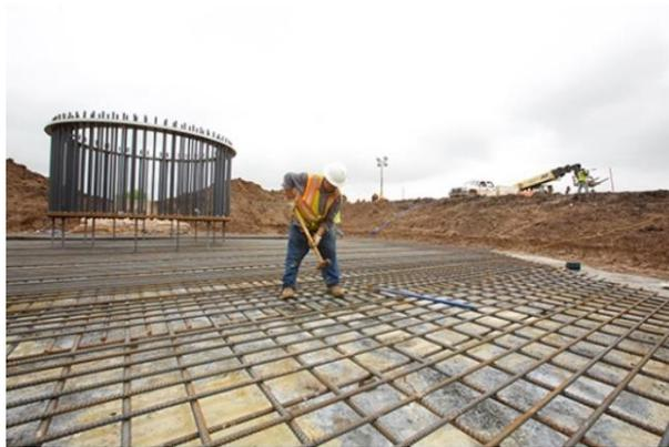
*Ilustración 39: Cimentación de un aerogenerador [48]*
