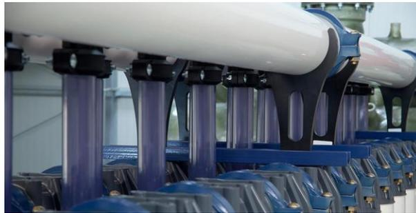
Ilustración 6: Sistema de ultrafiltrado de una desalinizadora [11]
