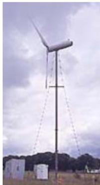
*Ilustración 36: Torre de mástil tensado con vientos*
