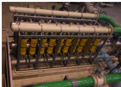
Ilustración 7: Sistema intercambiador de presión (SIP) [13]
