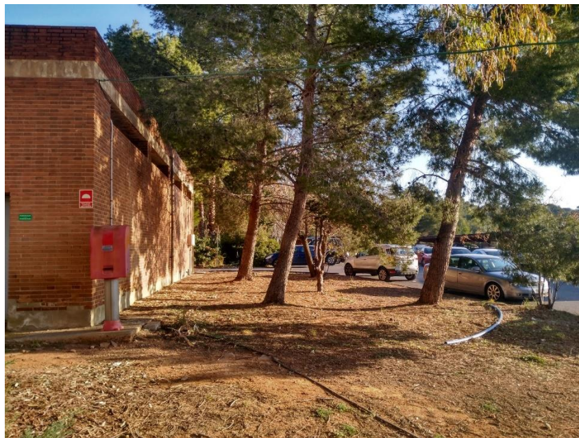
Figura 1.3-2 – Zona de Ampliación Sala de Calderas
