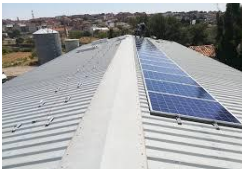
Ilustración 4 Ejemplo de estructura coplanaria
