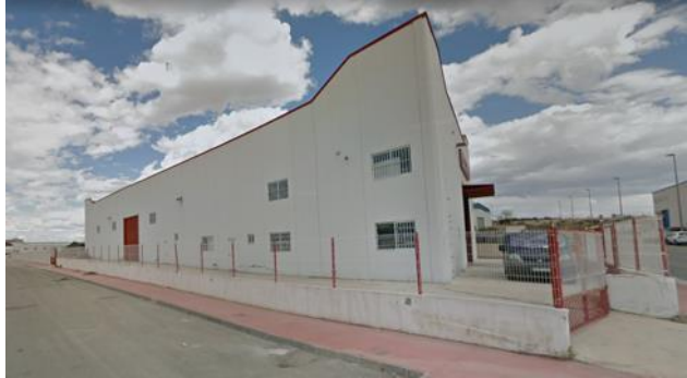
Ilustración 1: Foto de la nave donde se ubicarán los paneles.
