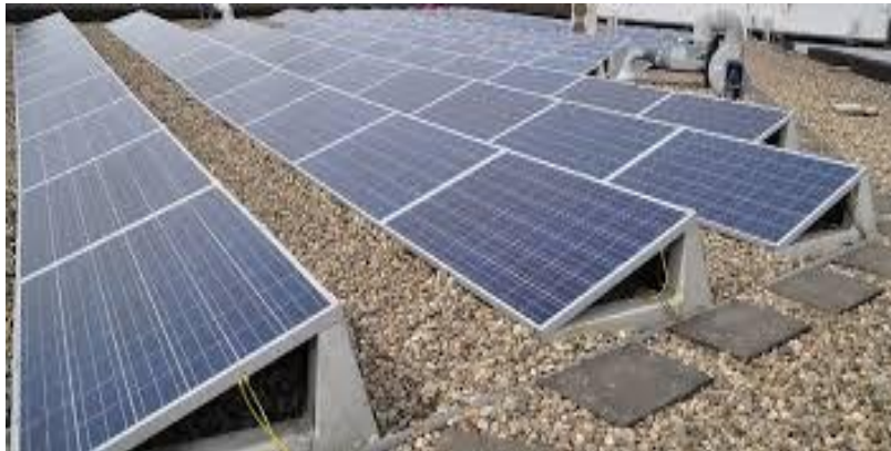
Ilustración 3 Ejemplo de instalación con estructura triangular
