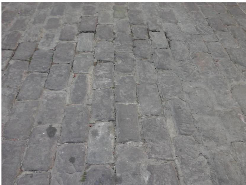
Imagen 45. Calzada de adoquines de piedra natural
