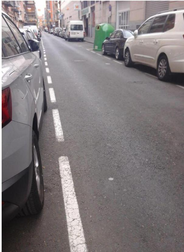
Imagen 67. Calzada con pavimento pulido
