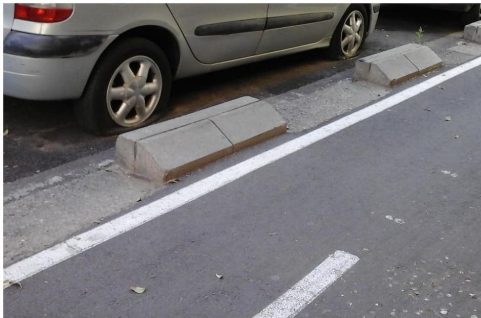
Imagen 22. Otro tipo de bordillo de hormigón
