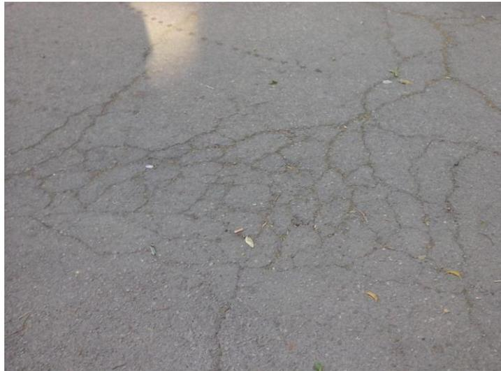
Imagen 50. Agrietamientos en calzada
