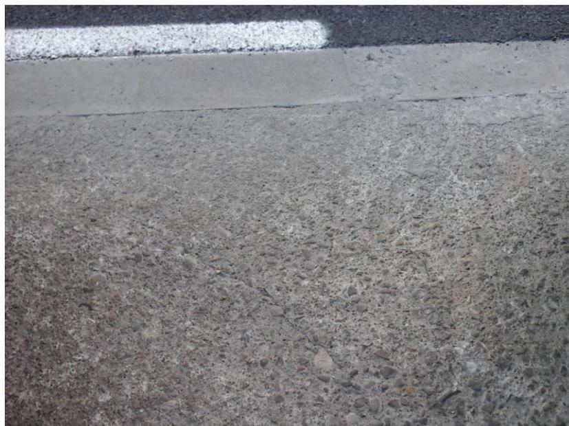
Imagen 58. Desgaste superficial en pavimento de hormigón
