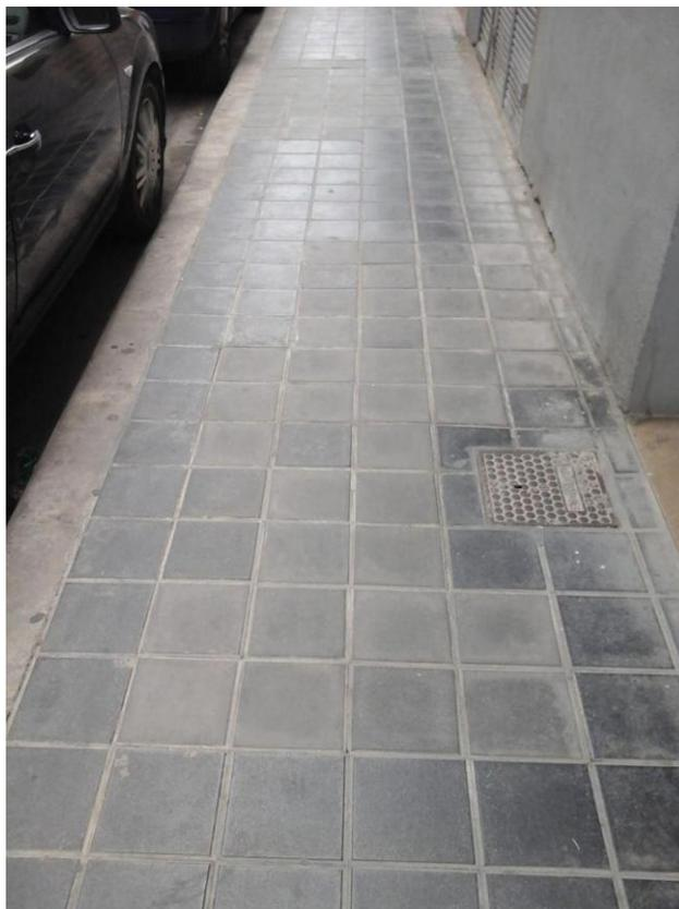
Imagen 6. Fotografía del pavimento de superficie de una acera
