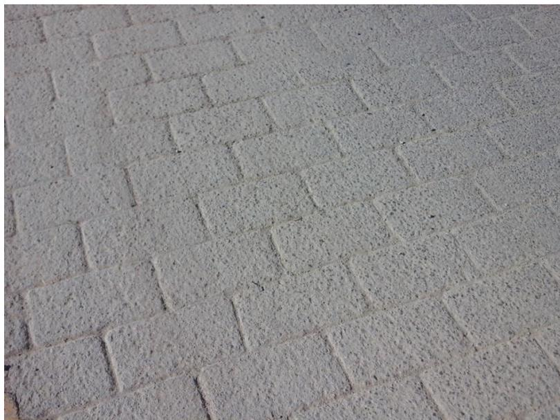
Imagen 59. Desgaste superficial en adoquines
