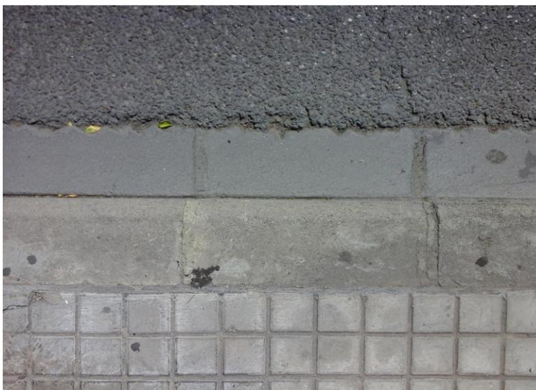
Imagen 24. Rigola de hormigón
