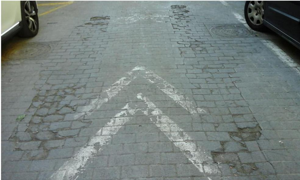
Imagen 170. Calzada de vehículos con adoquines rotos.
