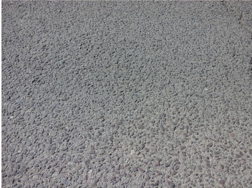
Imagen 55. Desgaste superficial de pavimento de rodadura
