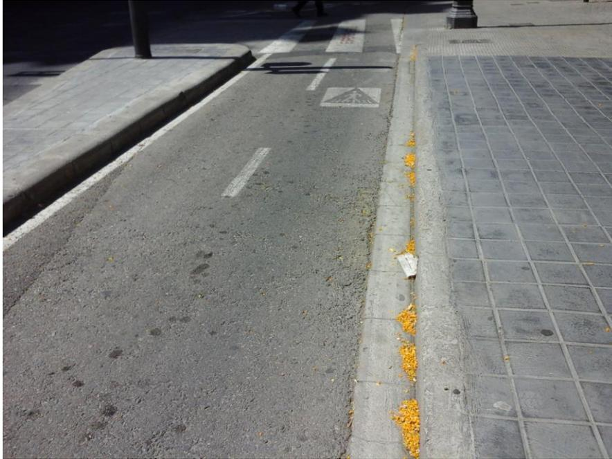
Imagen 160. Foto de carril bici con rigola al mismo nivel que el adoquinado
