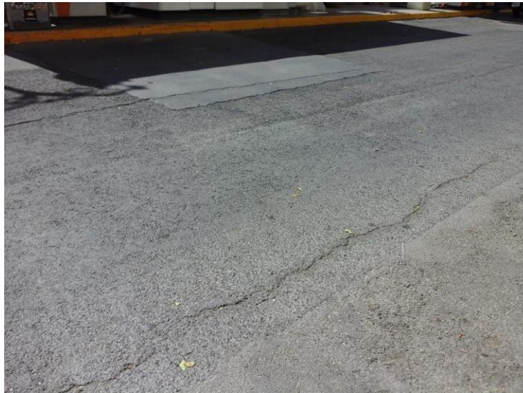
Imagen 61. Fisuras longitudinales en calzada
