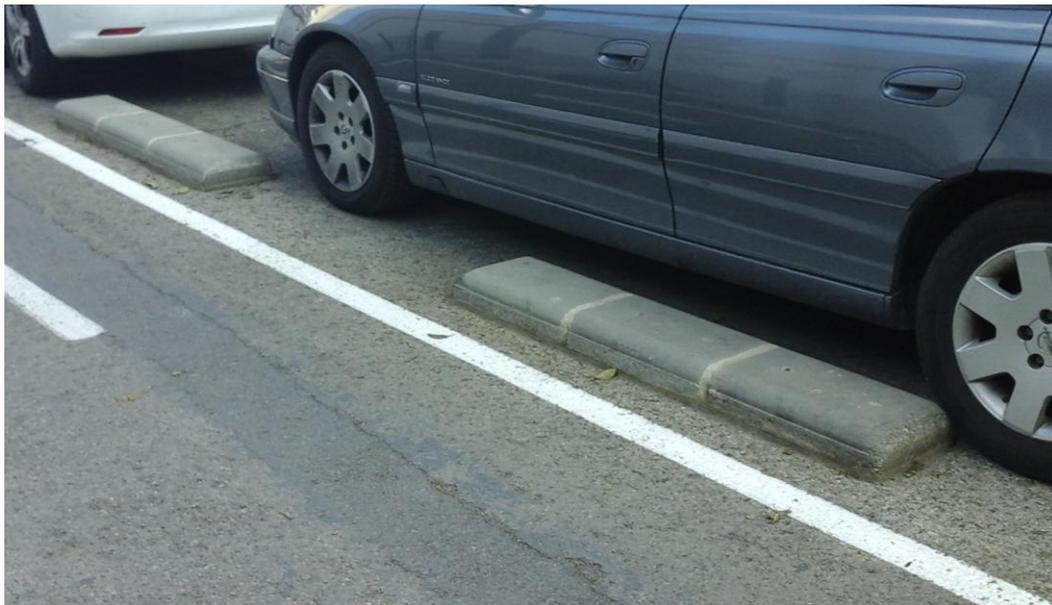
Imagen 21. Bordillo de hormigón en carril bici
