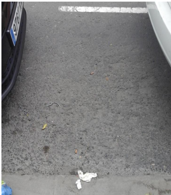
Imagen 104. Foto del estado del desgaste superficial del aparcamiento derecho
