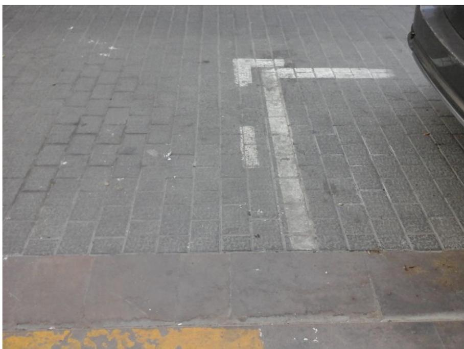
Imagen 41. Pavimento de adoquines en aparcamiento
