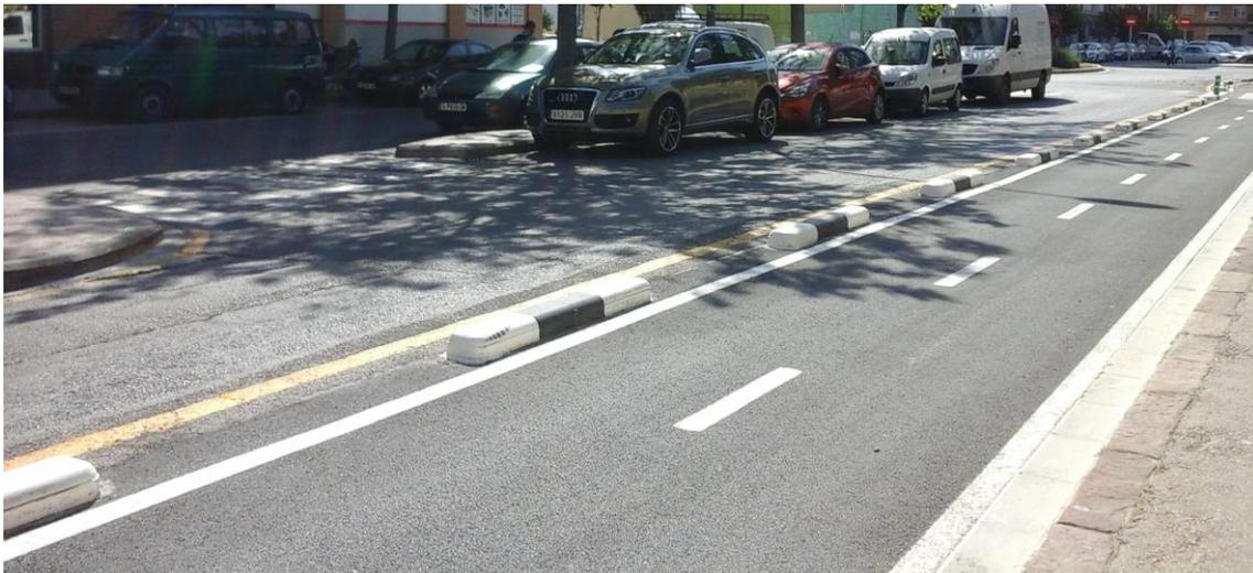
Imagen 153. Elemento separador de carril bici a nivel de calzada
