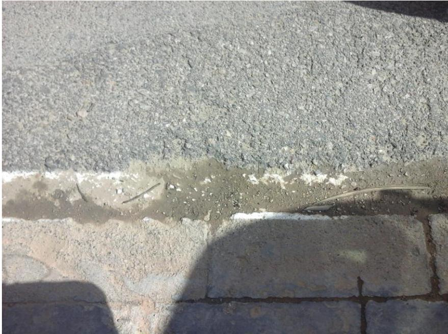
Imagen 64. Deficiencia en la unión entre aglomerado y rigola
