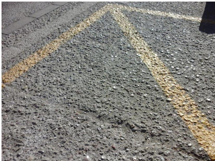
Imagen 57. Desgaste superficial en pavimento de aglomerado
