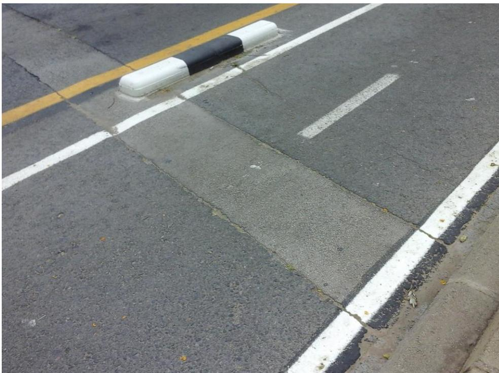
Imagen 172. Carril bici con zanjas irregulares
