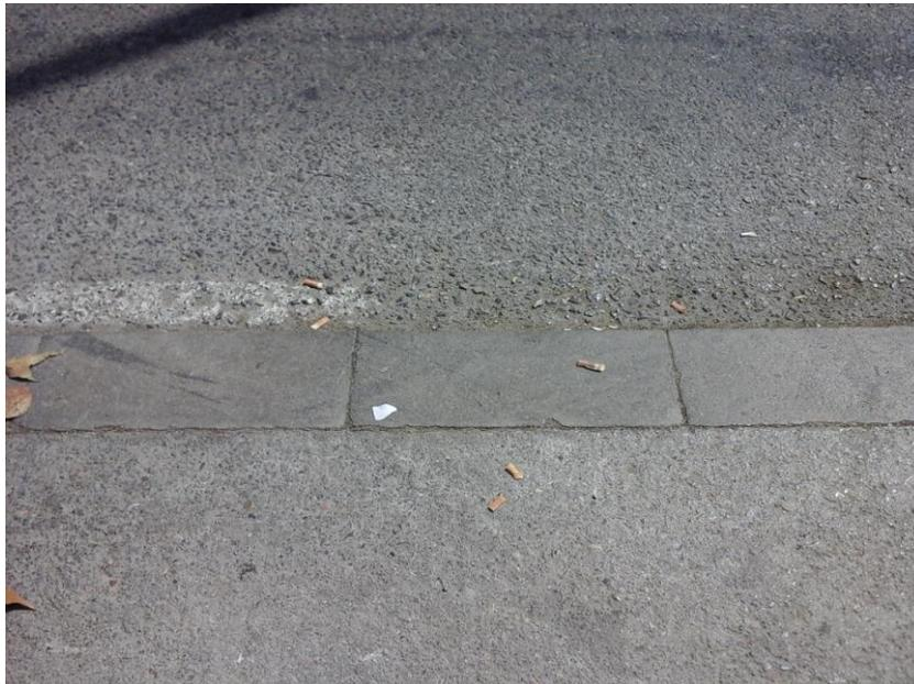
Imagen 10. Fotografía de una rigola en una zona de aparcamiento
