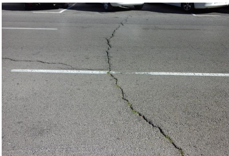
Imagen 62. Fisuras transversales en calzada
