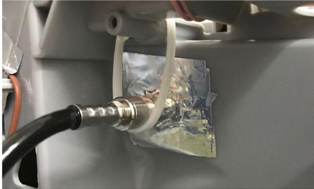
*Fig. 26 - Sonda de humedad instalada a la salida del condensador*
